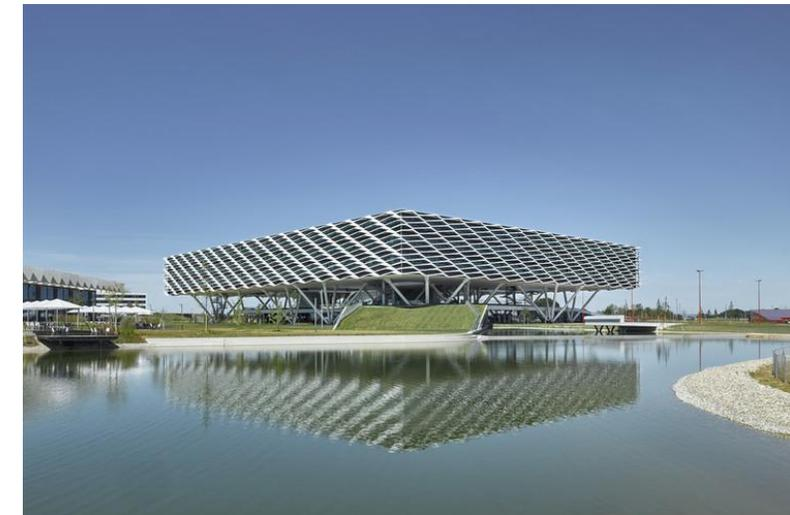
Oficinas en tres plantas a unos 10 metros de altura desde el suelo, apoyándolas sobre estructuras en árbol con pilares inclinados de acero reforzado con cemento
