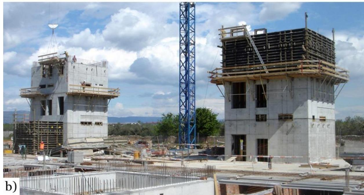
**Figura 7** a) Geometría de los alzados este y oeste del núcleo de visitas con las «orejas transversales» de sujeción de las armaduras longitudinales, b) Ejecución de los núcleos con encofrado autotrepante.
