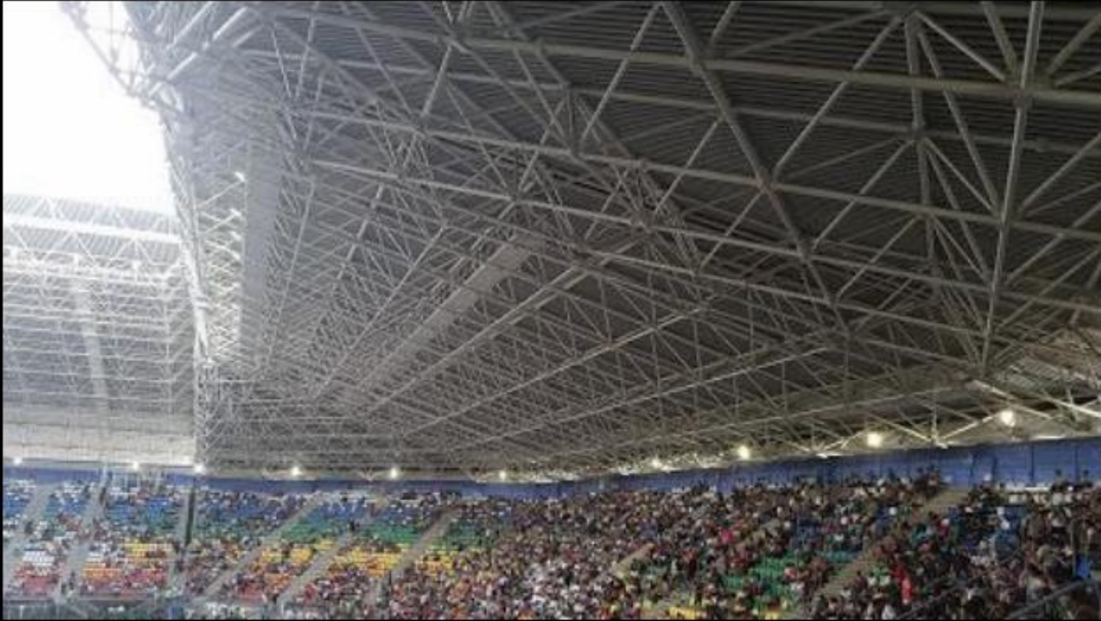
Grandes luces, cubierta metálica reticulada espacial o estereoestructuras
