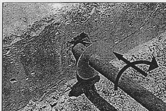
Esto se comprueba cuando el material rebalsa por la zona anular, caso contrario de repetirá el procedimiento. Para evitar que el material (aun no endurecido) se salga del orificio, se suele colocar un disco de retención que recubre al pasador
