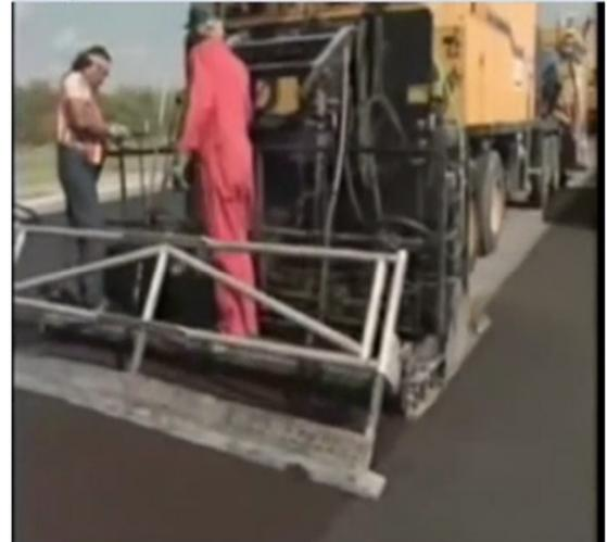
**Fig.12 Equipo ambulo-operante para elaboración y distribución de lechadas y microaglomerados asfálticos**
