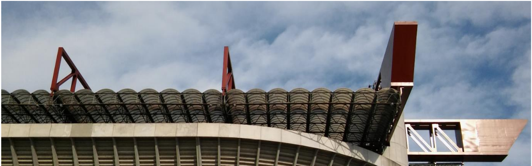
Estructura resistente cubierta de techos. Vigas reticuladas de grandes luces. Estadio Giuseppe Meazza. Milán.
