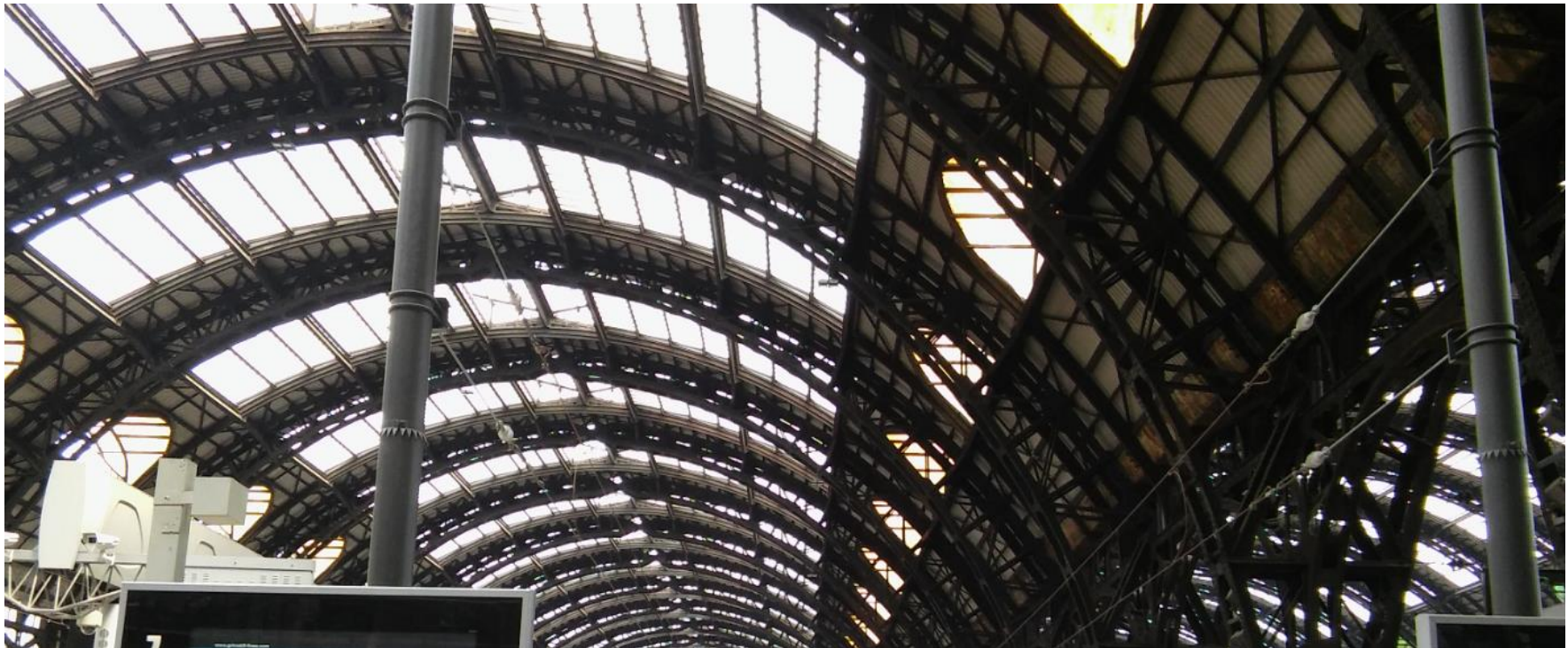
C ubierta de acero de grandes luces. Estación Terminal Ferroviaria
