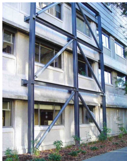
Fig. 3-12. Vista de un pórtico arriostrado de acero utilizado para la rehabilitación de una estructura existente de hormigón armado.
