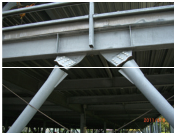
Fig. 1-28. Fractura de riostras en la zona de conexión (Midorikawa et al., 2012).
