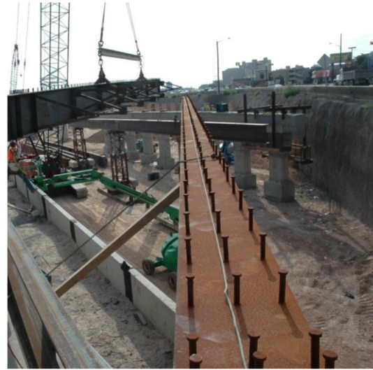
Fig. 1-39. Imagen de una viga de acero con pernos de corte para construcción de la viga compuesta de un puente.
