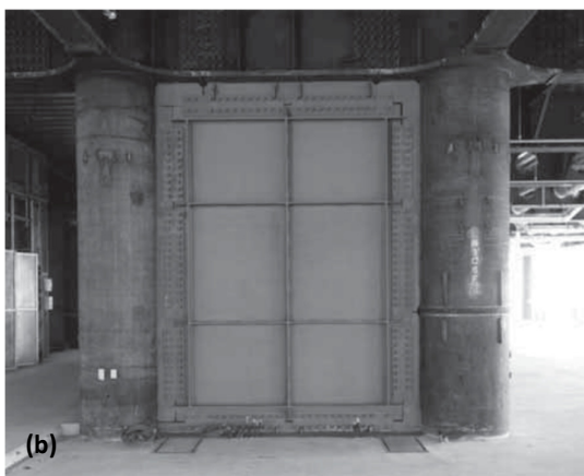
Fig. 8.3. Imágenes de muros de corte con (a) rigidizadores horizontales y (b) rigidizadores verticales y horizontales ( Sabelli y Bruneau, 2006 ).
