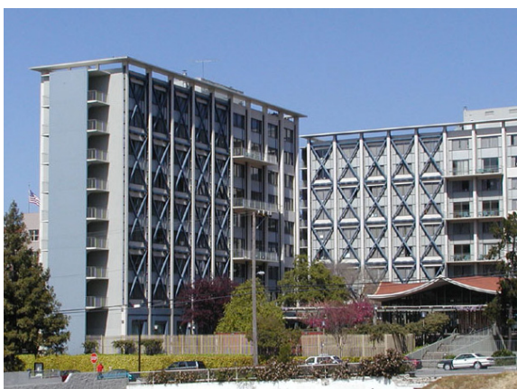
Fig. 5-53. Edificio Residence Hall, Berkely, Estados Unidos, rehabilitado con riostras de acero.
