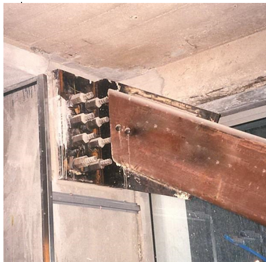
Fig. 5-55. Detalle de la conexión de una riostra de acero al nudo de un pórtico existente de hormigón armado.
