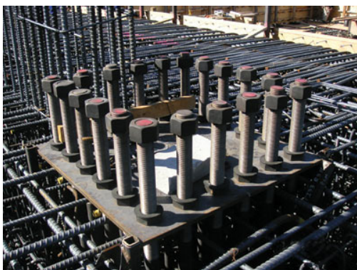
Fig. 3-65. Ejemplo de base de columna embebida en una viga de fundación de hormigón armado ( http://www.structuremag.org ).
