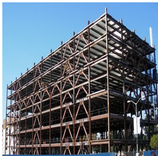
Fig. 3-7. Vista de un edificio en construcción con pórticos arriostrados.
