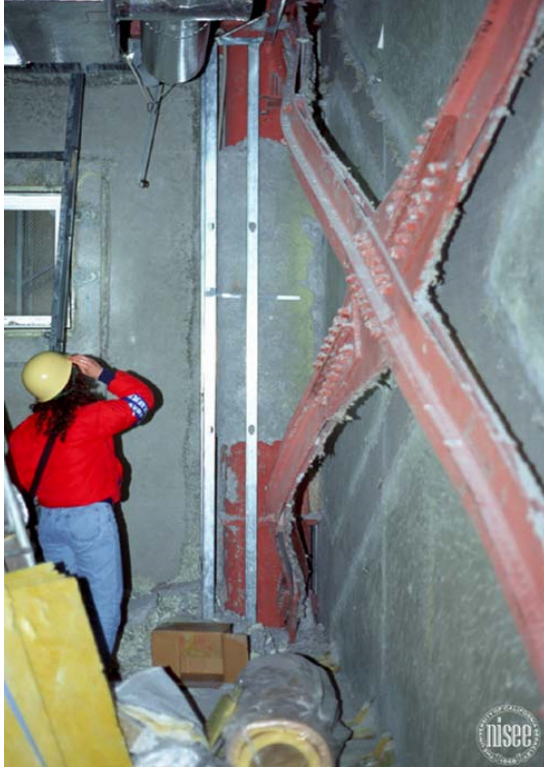
Fig. 1-11. Pandeo de una riostra, terremoto de Hyogo-ken Nanbu, Japón (Cortesía de National Information Service for Earthquake Engineering, EERC, University of California, Berkeley).
