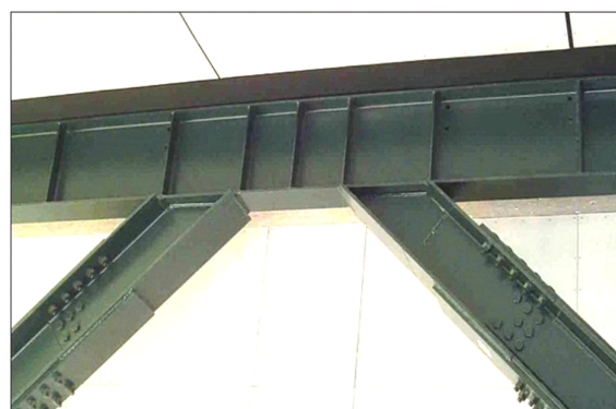
Fig. 3-17. Detalle del enlace en un pórtico con arriostramientos excéntricos
