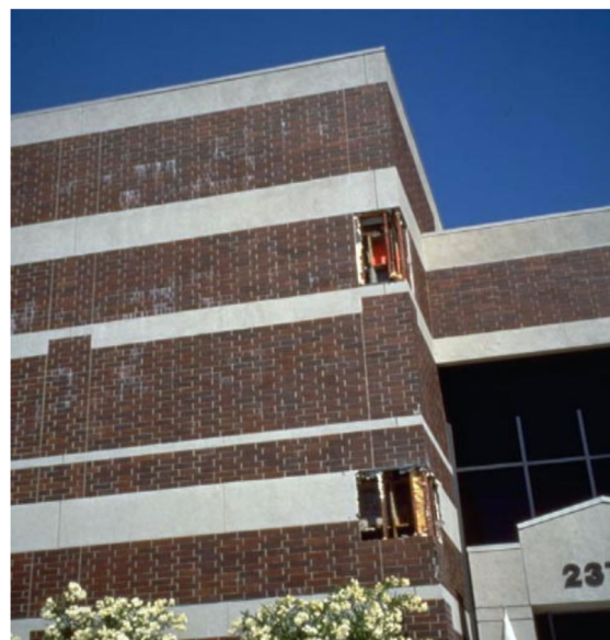
Fig. 1-21. Edificio bajo inspección para observar los daños causados por el terremoto en las conexiones viga-columna ( Earthquake Engineering Research Institute, Slides on the January 17, 1994, Northridge Earthquake, Set I: An Overview ).
