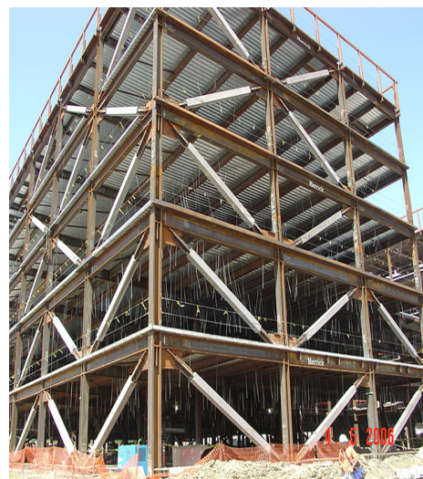
Fig. 3-20. Pórtico de acero con riostras de pandeo restringido.
