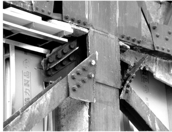
Fig. 1-27. Fractura en una conexión soldada (Naeim, 2001).
