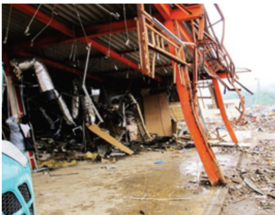
Fig. 1-30. Desplazamiento lateral excesivo del primer piso de una estructura aporticada ( Midorikawa et al., 2012 ).
