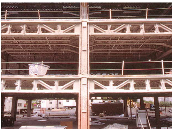
Fig. 3-5. Pórtico no arriostrado con vigas reticuladas, que incluyen 2 segmentos con panel Vierendeel (Chao y Goel, 2006).
