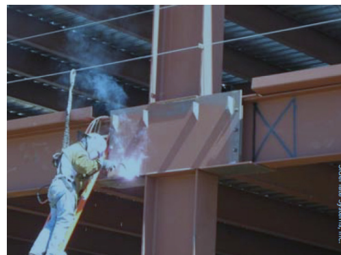
Fig. 4-29. Conexión con placas laterales.
