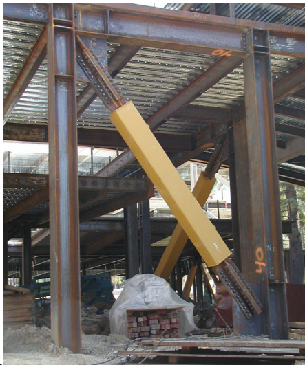
Fig. 3-21. Vista de una riostra de pandeo restringido utilizada en nuevo edificio de la Universidad de California, Berkeley (Cortesía de EERC, University of California, Berkeley).
