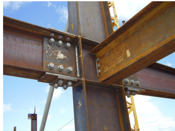
Fig. 4-25. Conexiones con placa apernada al ala.
