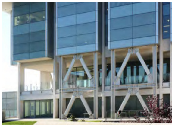
Fig. 7-16. Aplicación de riostras de pandeo restringido para la rehabilitación del edificio de la Biblioteca Marriott de la Universidad de Utah.
