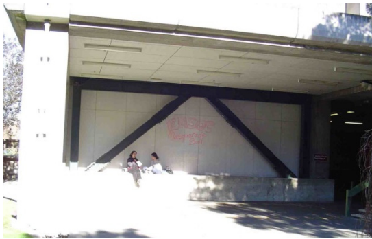
Fig. 6-21. Pórtico arriostrado excéntricamente adosado a una construcción de hormigón armado existente.
