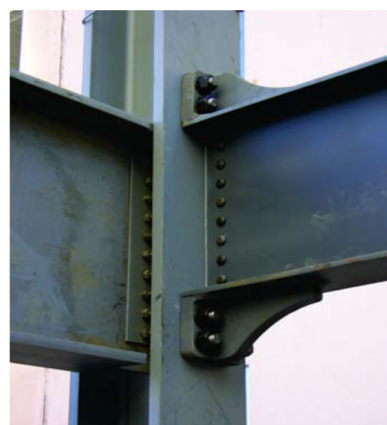
Fig. 4-27. Conexión “Kaiser” con soportes de alta resistencia apernados (a) esquema ( AISC, 2010c ) e imagen de una conexión real ( Cordova y Hamburger, 2011 ).
