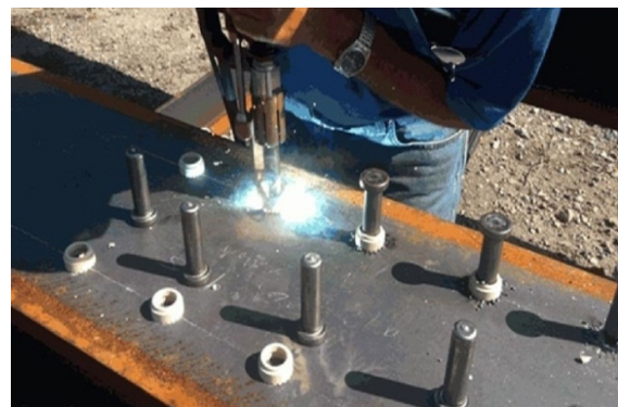
Fig. 1-33. Colocación de pernos soldados sobre el ala de una viga de acero.
