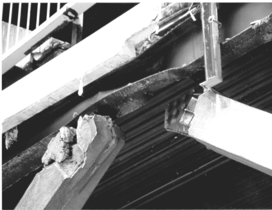
Fig. 1-26. Daño severo en la viga y conexión de un pórtico con arriostramientos en V invertida (Naeim, 2001).
