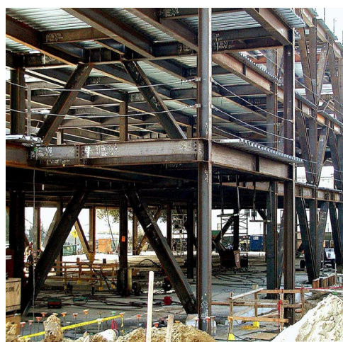
Fig. 3-14 Ejemplos de pórticos con arriostramientos excéntricos (Cortesía de National Information Service for Earthquake Engineering, EERC, University of California, Berkeley).
