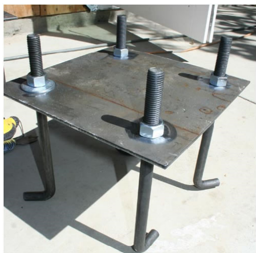
Fig. 3-66. Barras de anclaje previo a su colocación en las fundaciones.
