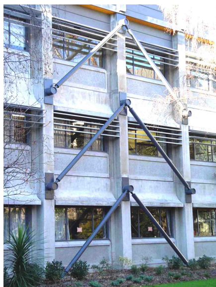
Fig. 3-13. Ejemplo de rehabilitación mediante el agregado de riostras de acero a una estructura de hormigón armado.
