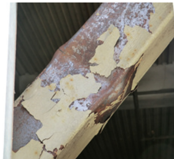
Fig. 1-29. Pandeo local de una riostra de acero (Midorikawa et al., 2012).
