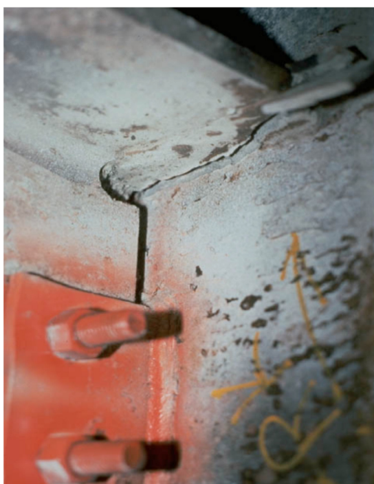
Fig. 1-23. Fractura de la soldadura de penetración completa en una conexión de pórtico resistente a momento (Earthquake Engineering Research Institute, Slides on the January 17, 1994, Northridge Earthquake, Set I: An Overview).
