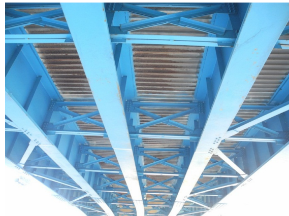
Fig. 3-57. Vista inferior de un puente carretero con arriostramientos torsionales.
