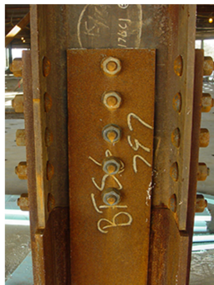
Fig. 3-58. Empalme en columna sin cambio de sección.
