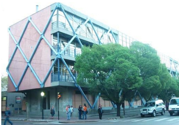
Fig. 5-52. Edificio escolar en la ciudad de Mendoza, Argentina, con estructura de hormigón armado, rehabilitado con el agregado de riostras de acero.
