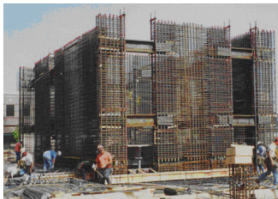
Fig. 3-47. Muros compuestos acoplados con vigas de acero ( Lehmkuhl, 2002 ).
