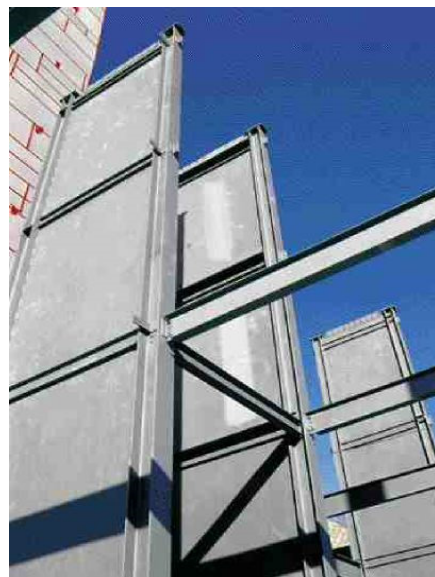
Fig. 3-24. Ejemplo de muros de corte con placas de acero en un edificio en construcción.
