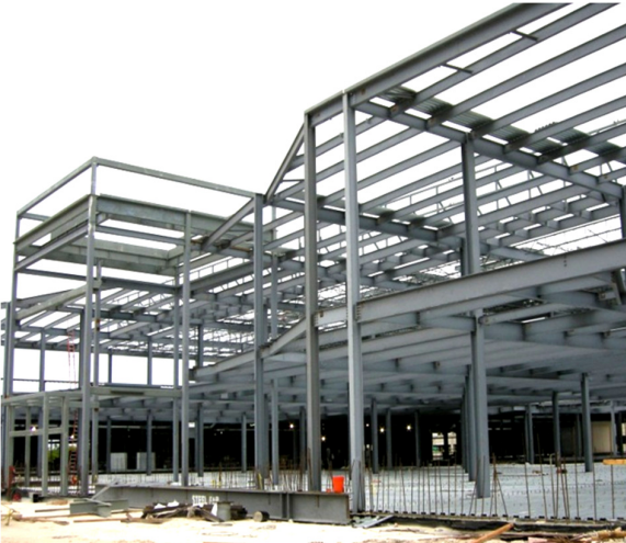
Fig. 3-3. Vista general de una estructura de pórticos no arriostrados para un edificio comercial.
