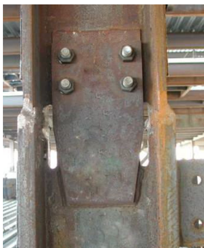
Fig. 3-60. Empalme en columna con alas soldadas
