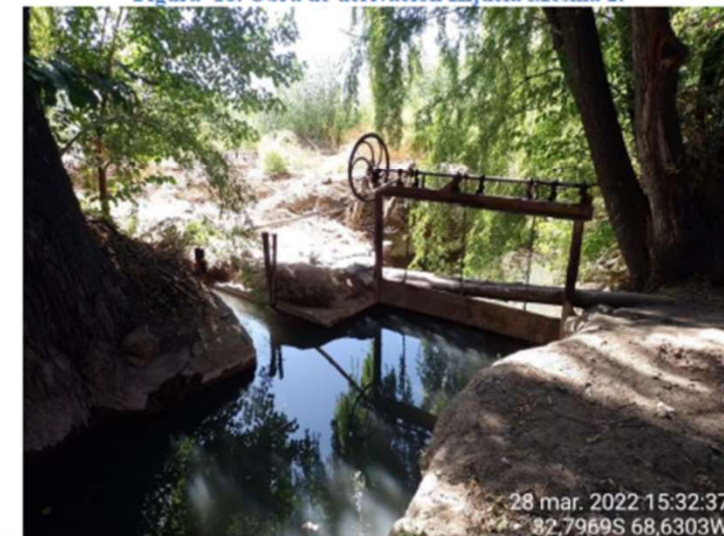
Figura 18. Obra de derivación Higuera Mesina 2.
