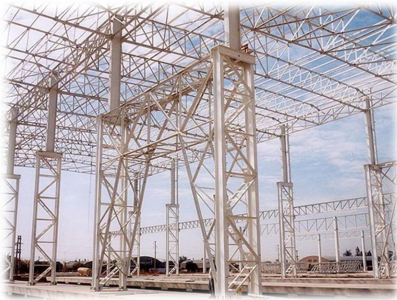
Estructura de una nave industrial, donde se observa claramente la esbeltez de las barras.
