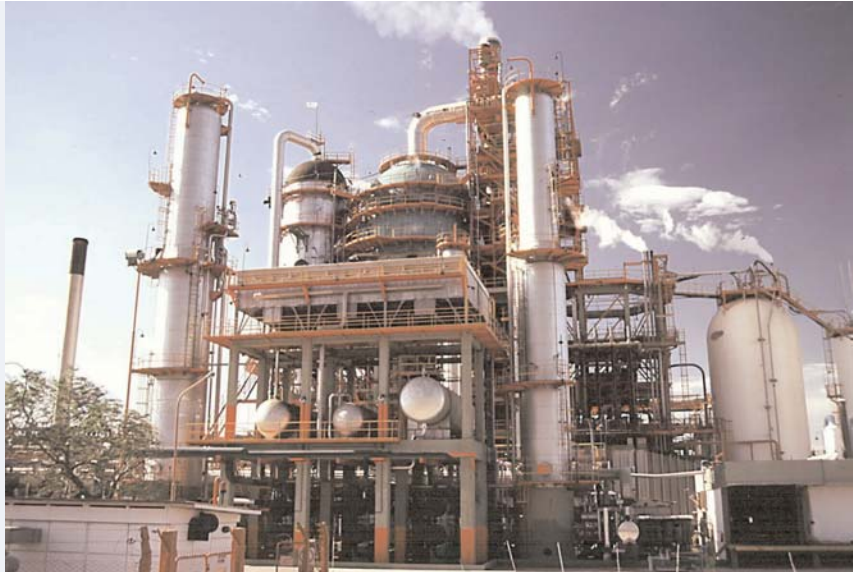
Unidad de Cracking Catalítico a lecho fluidizado modelo Side by Side, similar Fig. 56
