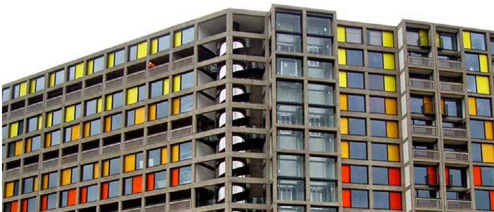
Fig. 20 Vista de las escaleras y el ascensor.
