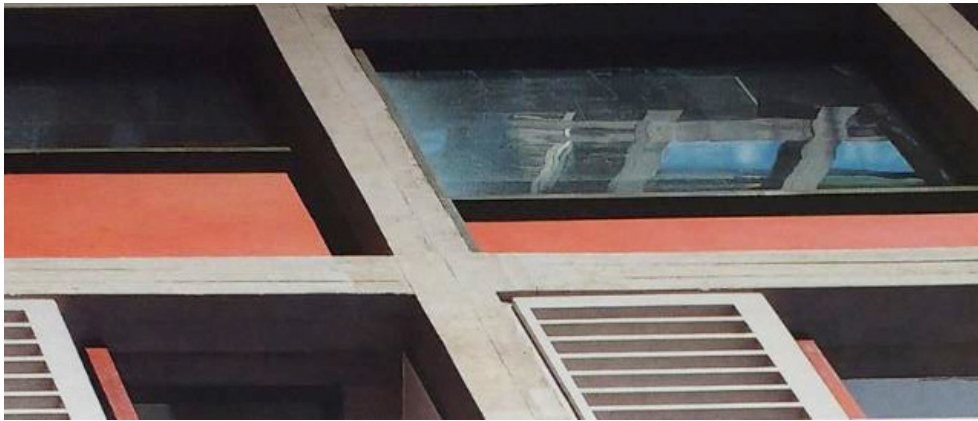
Fig. 16 Detalle del hormigón restaurado.
