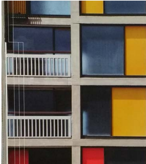
Fig. 18 Aspecto de las antiguas barandillas. En Architect's Journal.
