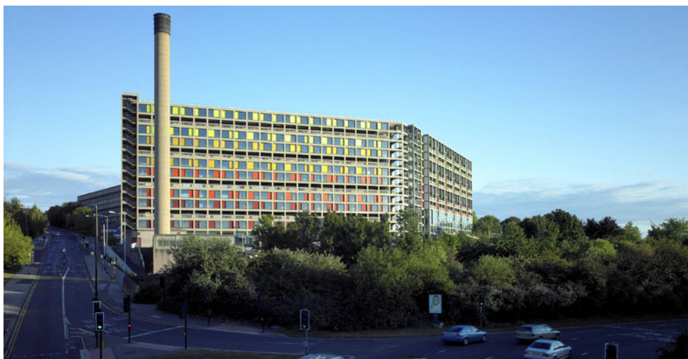
Fig. 61 Vista de la chimenea con el bloque reformado. Foto de Keith Collie en Detail.
