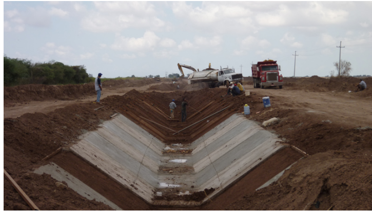
Figura 10: Construcción de un canal para riego
