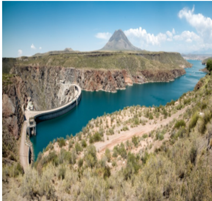
FIGURA 34. Presa de Agua del Toro.
