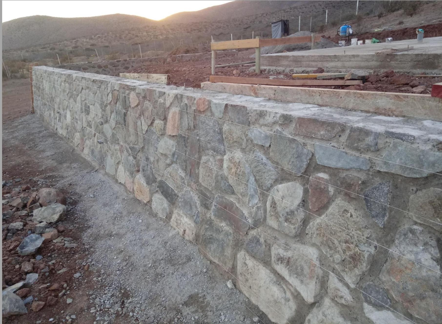
Antes se conocía como “ciclópea” a la técnica constructiva basada en la utilización de bloques de piedra de grandes dimensiones que, superpuestos y vinculados entre sí, sin ningún tipo de argamasa o mortero, permitían materializar diversas estructuras.
