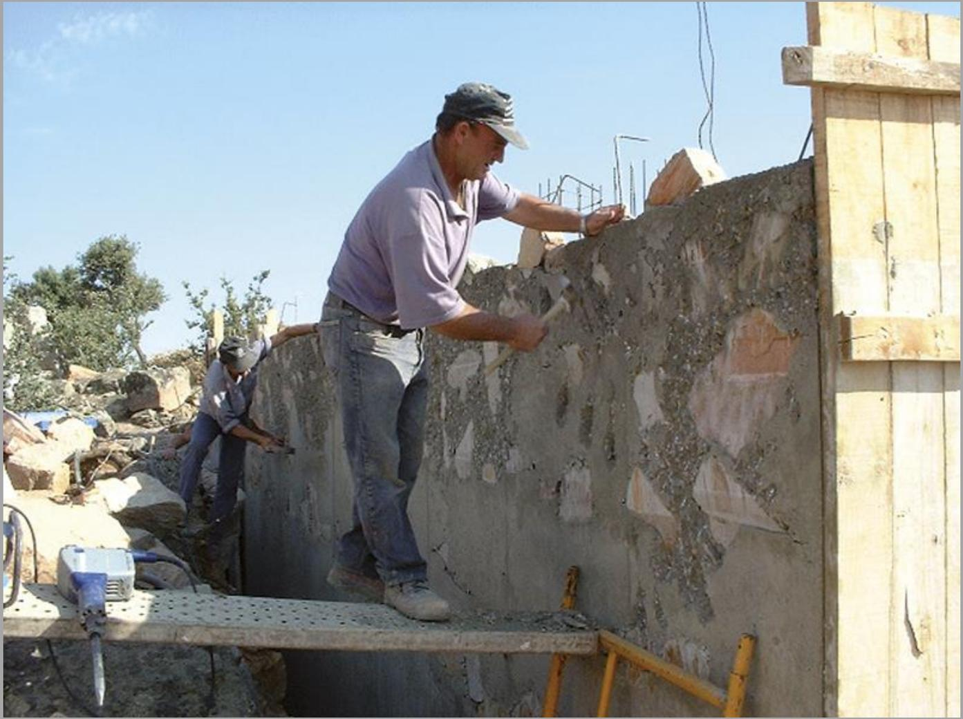
En la Casa Del Horizonte de Jesús Aparicio, los muros perimetrales se componen con un hormigón ciclópeo formado por piedras de una cantera ubicada en las proximidades de la vivienda.
