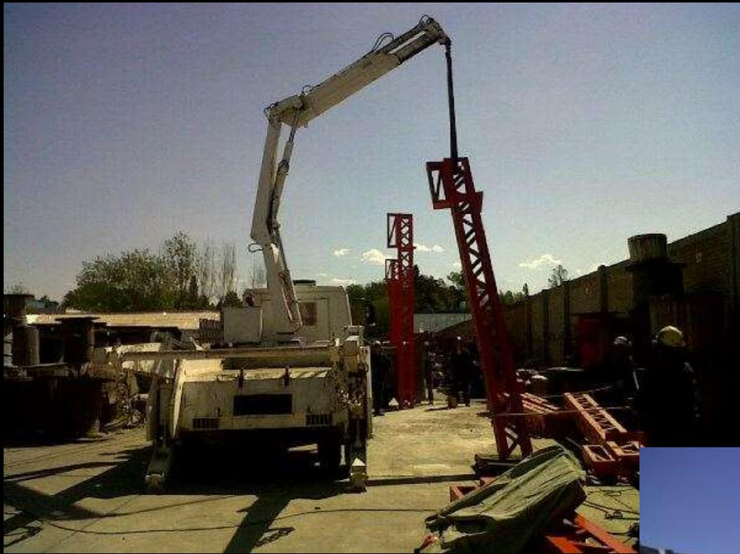
Montaje y colocación de una columna metálica soldada.
