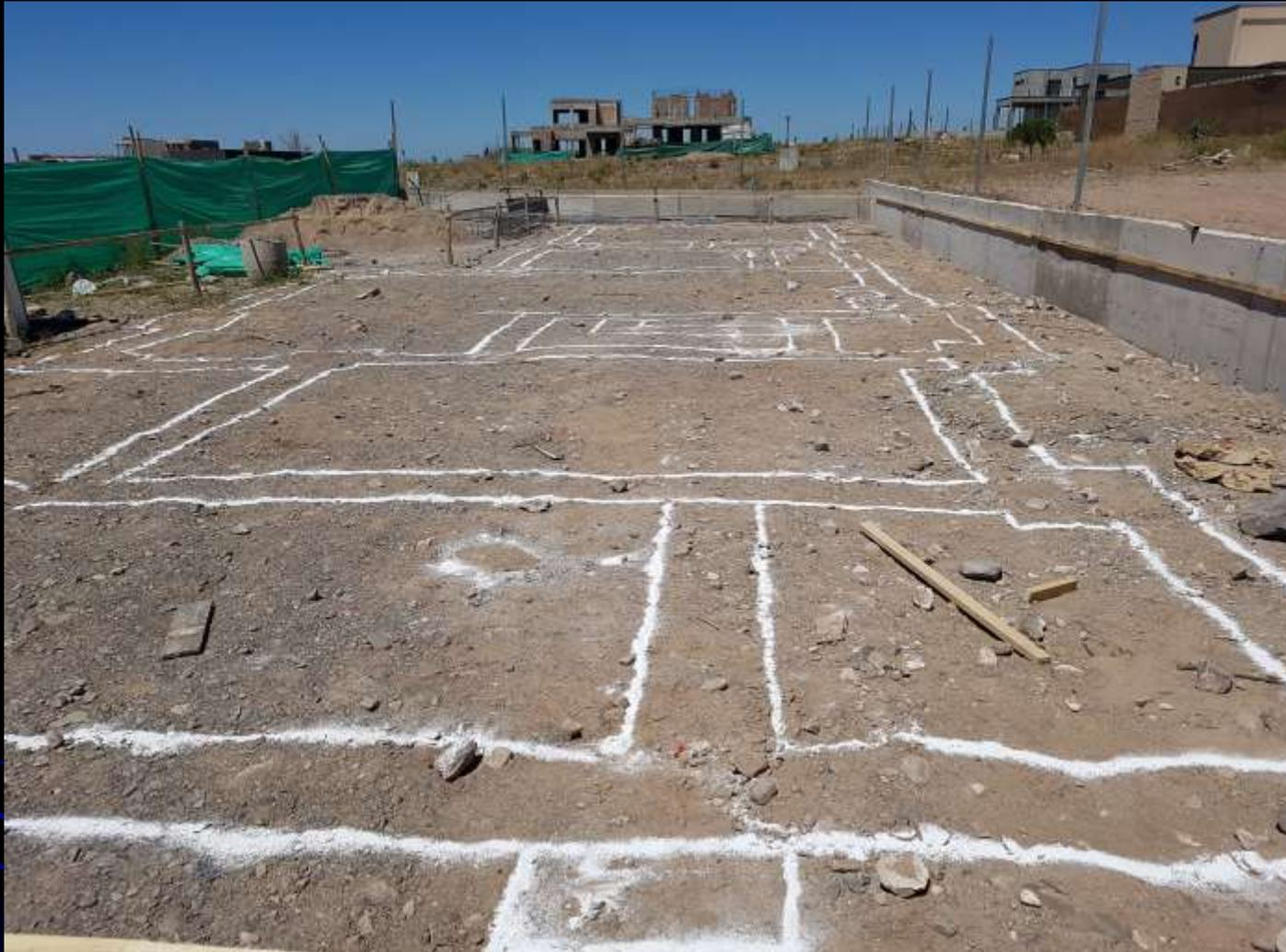
Una vez marcado en el terreno las fundaciones (con cal y tomando como referencia los hilos del replanteo) bases y cimientos, se comienza con la excavación del terreno, la cual puede ser manual o con máquinas
