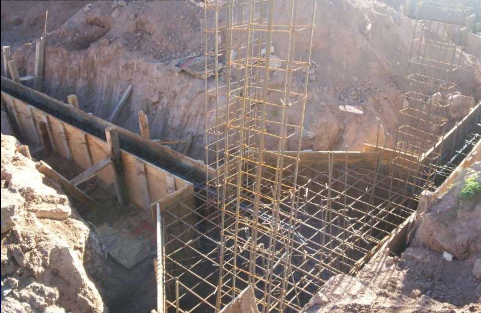
Base aislada, armadura tipo canasto con columna posicionada y alineada.
