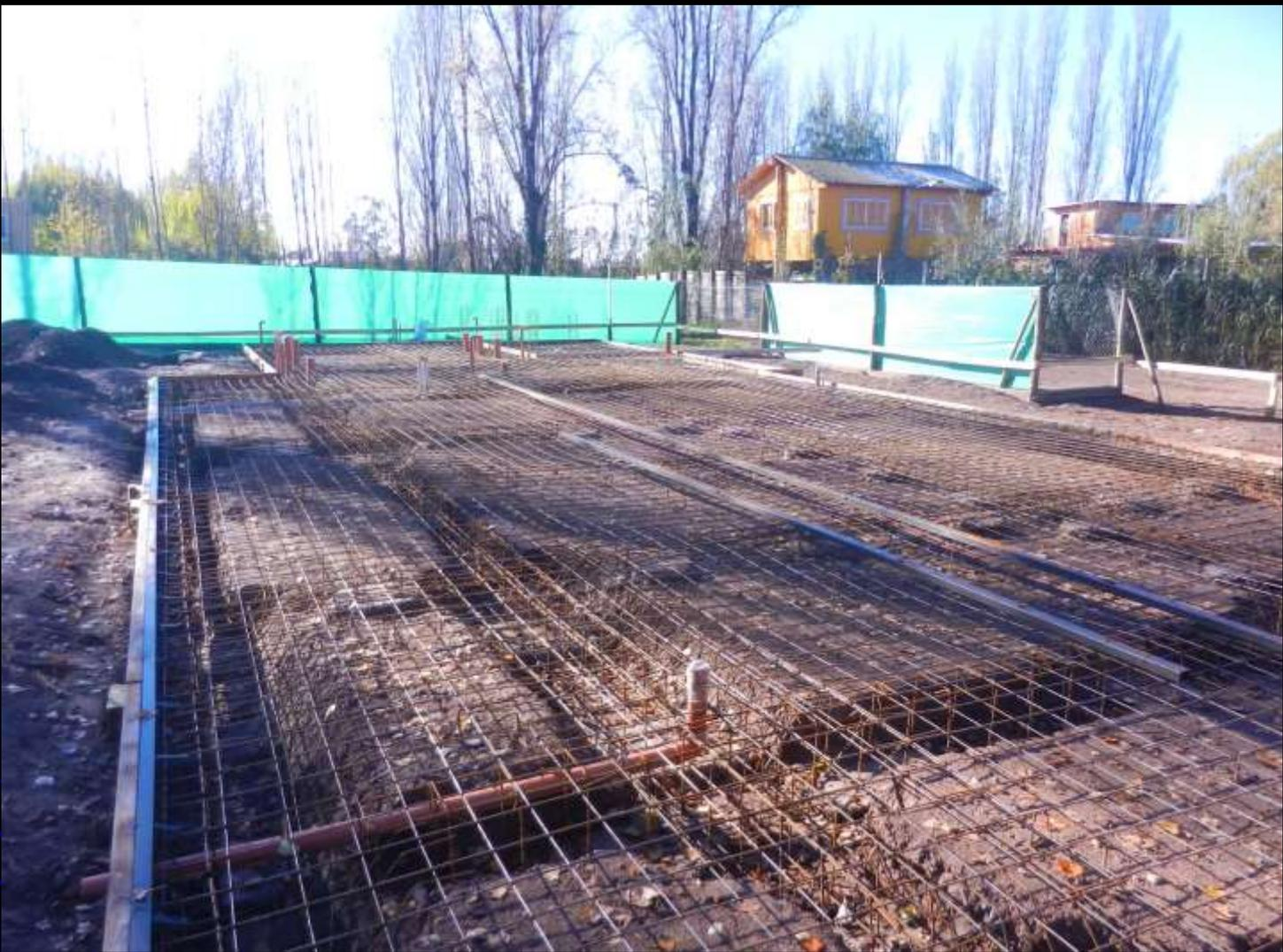
Las plateas de fundación al estar constituidas por una losa de hormigón armado apoyada en el terreno, implica que se debe dejar previamente al hormigonado todas las instalaciones bajo piso colocadas y posicionadas con precisión. Además de todos los recaudos constructivos necesarios para poder montar y fijar posteriormente toda la superestructura.
