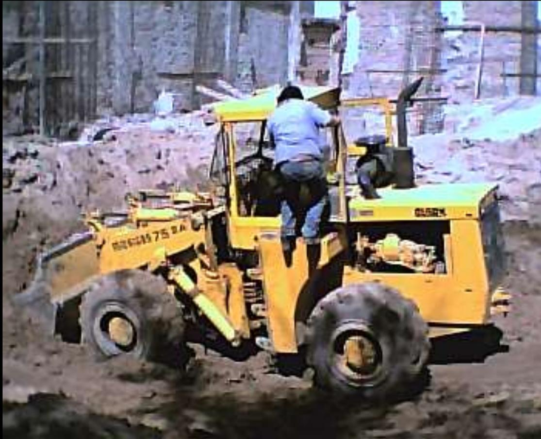
Si el tipo de fundaciones y las dimensiones de la obra lo permiten, las excavaciones pueden ser realizadas por medios mecánicos (cargadora frontal en este caso) lo cual incrementa notablemente el rendimiento de las tareas y acorta los plazos.
