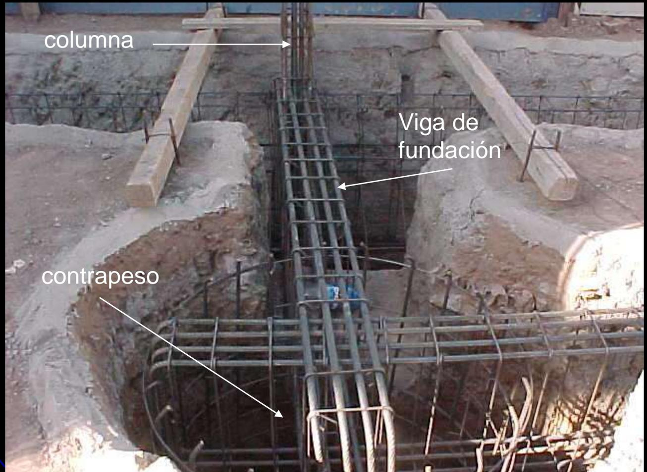
Por medio de una viga de fundación muy rígida transmite la columna el vuelco y este es balanceado por el contrapeso.
