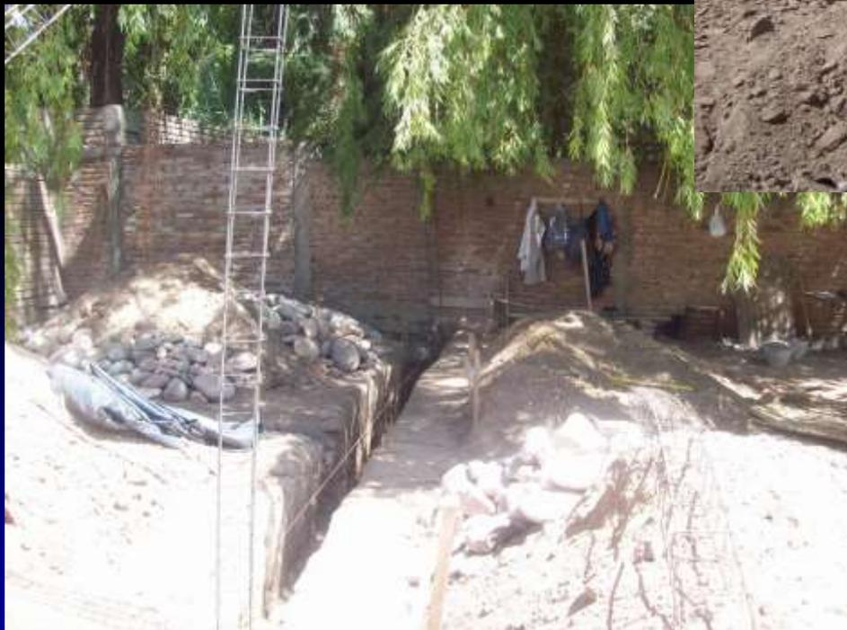
Una técnica utilizada en zonas donde la napa freática esta alta es la de colocar en el fondo de cimientos, polietileno como aislante hidrófugo. Se debe tener precaución al parar las columnas, de no romper con los hierros las láminas de polietileno.
