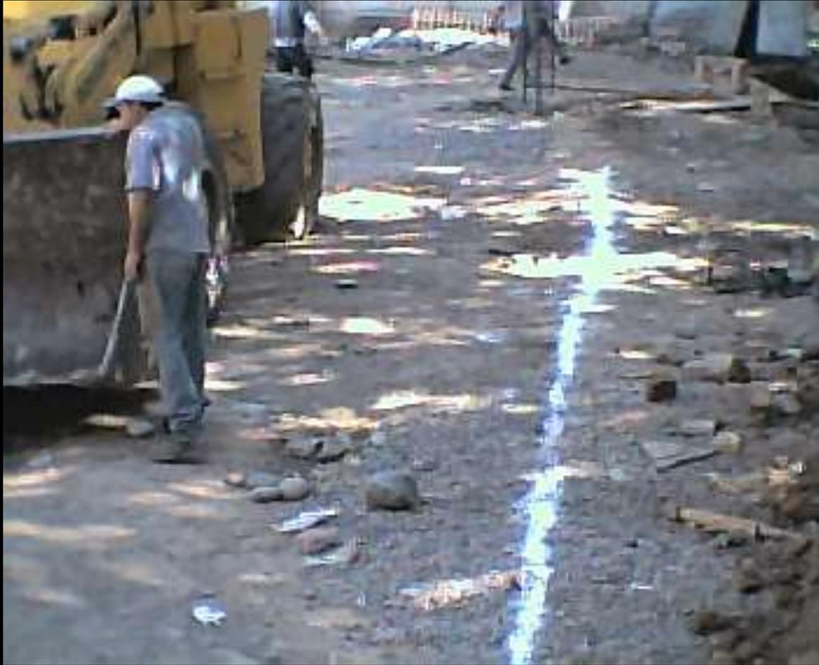
La primera tarea a realizar es delimitar o marcar las zonas a excavar, se realizan sobre el terreno natural limpio, con cal, y tomando como referencia las medidas indicadas en el replanteo.
