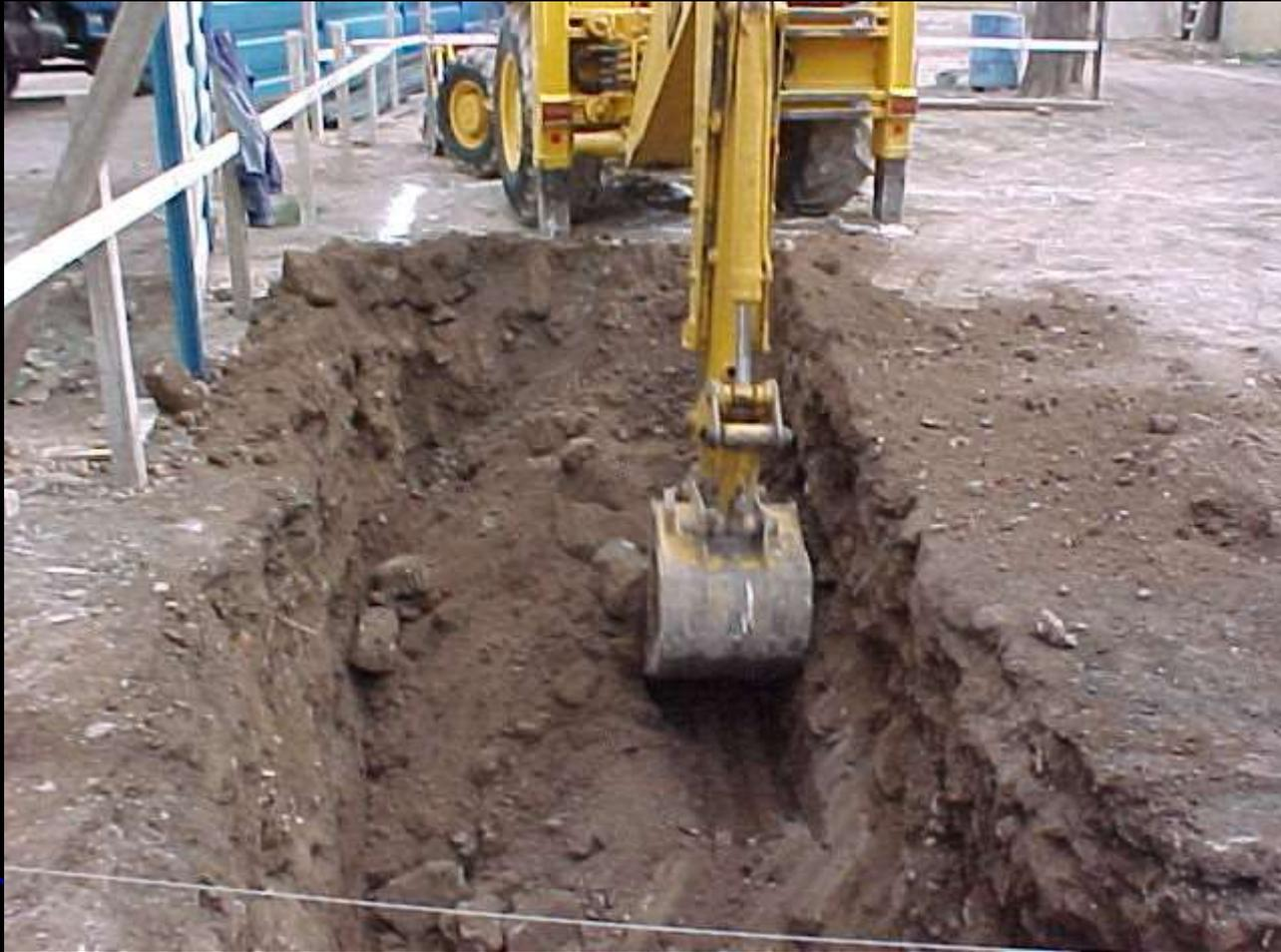
Si el tipo de fundaciones y las dimensiones de la obra lo permiten, las excavaciones pueden ser realizadas por medios mecánicos (retroexcavadora en este caso) lo cual incrementa notablemente el rendimiento de las tareas y acorta los plazos de obra.
