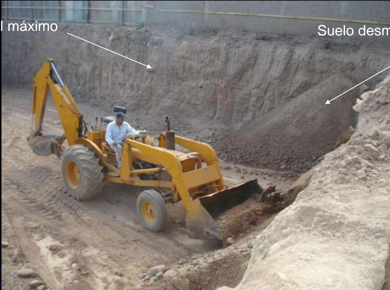
Si el tipo de suelo y las dimensiones de la obra lo permiten, las excavaciones pueden ser realizadas por medios mecánicos (retroexcavadora en este caso). Se excava hasta llegar a lo llamado el “talud natural” que es la máxima pendiente que permite el suelo sin desmoronarse. Superado este talud el suelo puede desmoronarse, pudiendo provocar inclusive accidentes.
