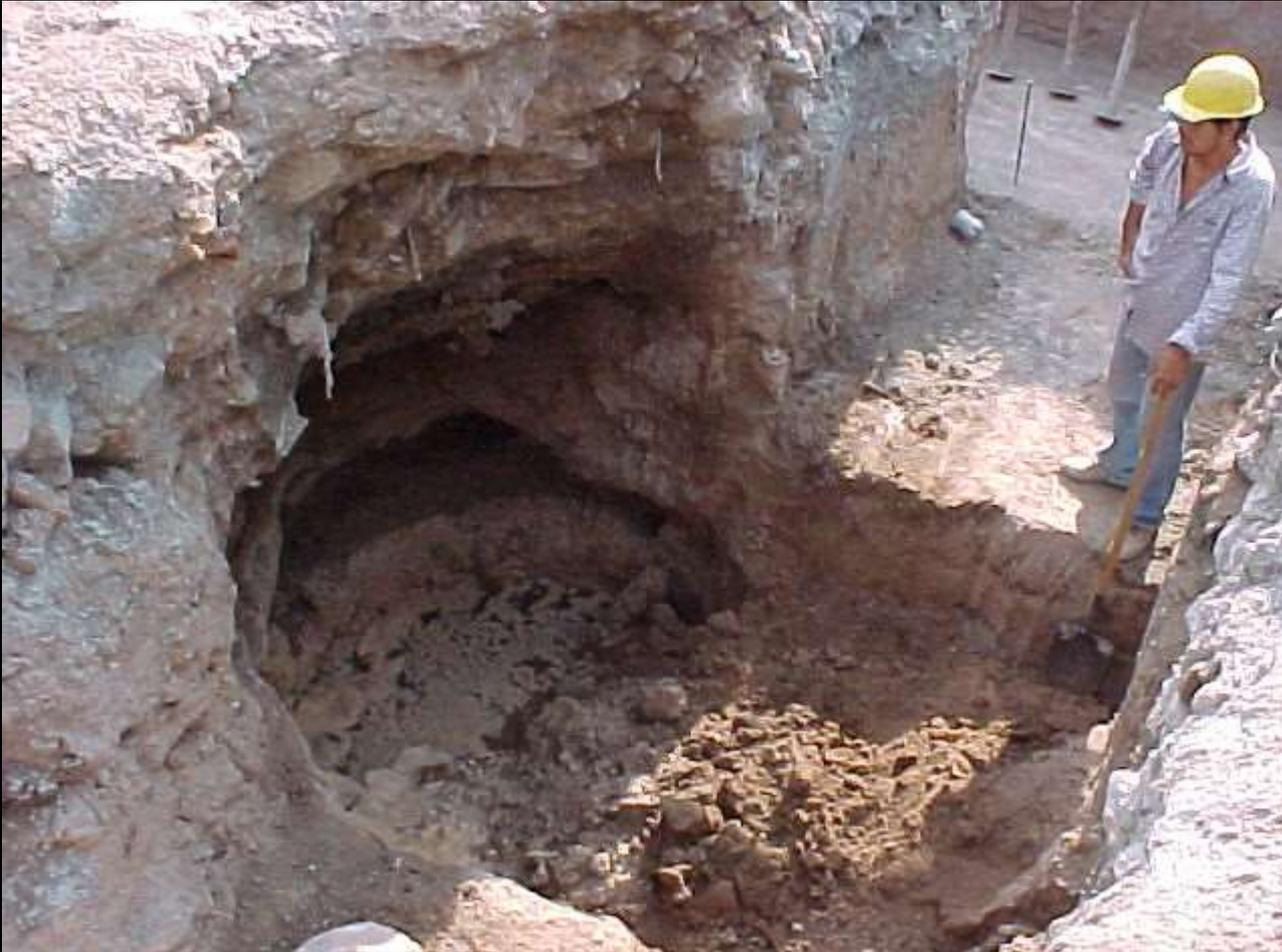
Desmoronamiento de un pozo al superarse la cohesión del terreno y tener agua.
