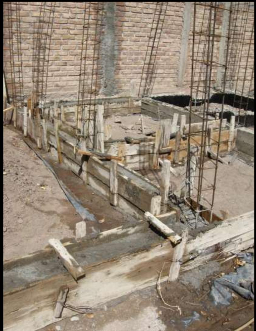
Una vez terminado el llenado de cimientos y bases, se procede a la colocación de armaduras de viga de fundación, encofrado y llenado. El alineamiento de las vigas debe hacerse también con hilos utilizando las marcas realizadas en el replanteo, por lo cual éste debe permanecer confiable hasta esta etapa de trabajo.
