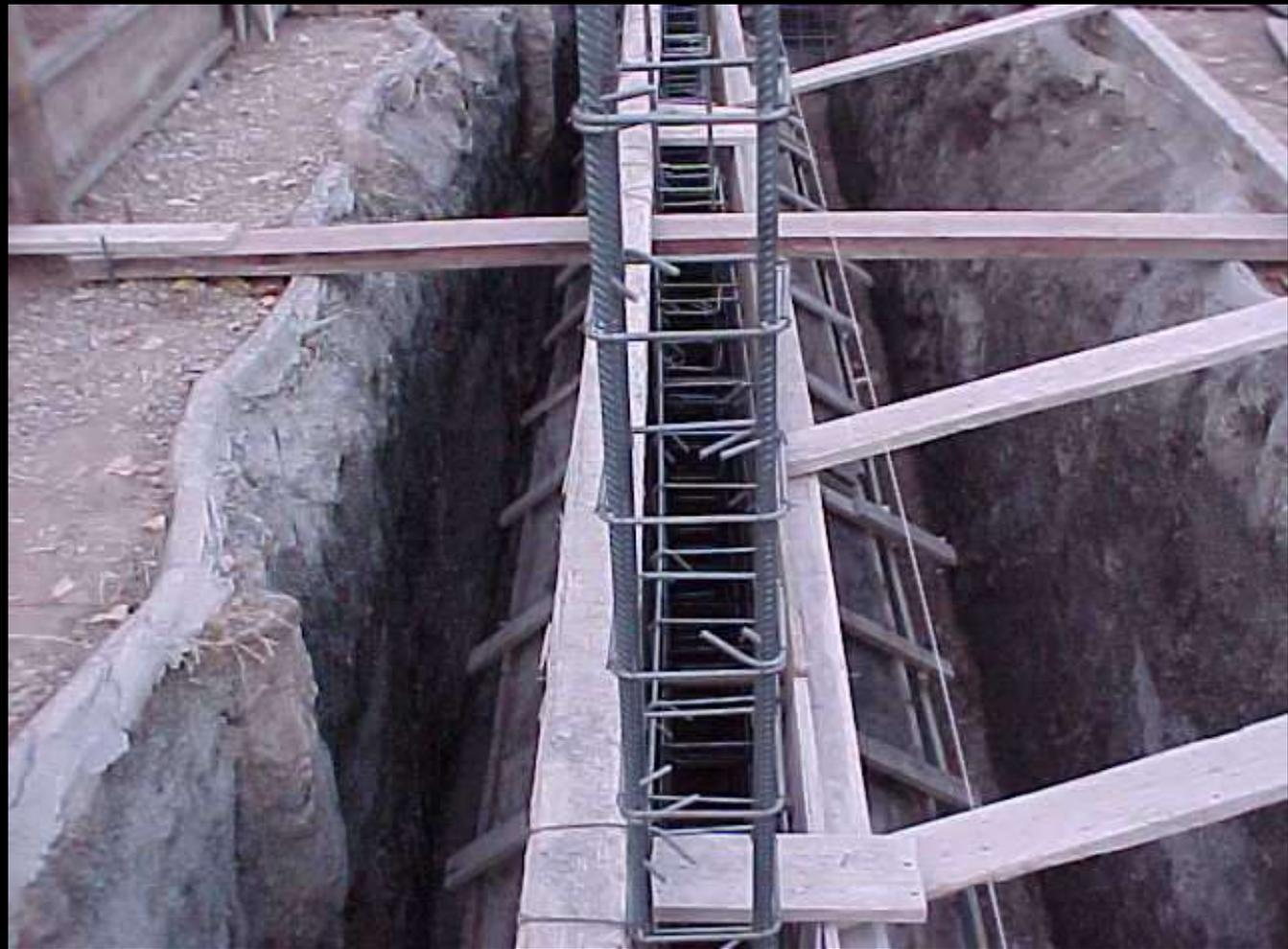
Zapatas combinadas, bases corridas o zapata continúa, cuya parte superior o “talón” se puede encofrar.
