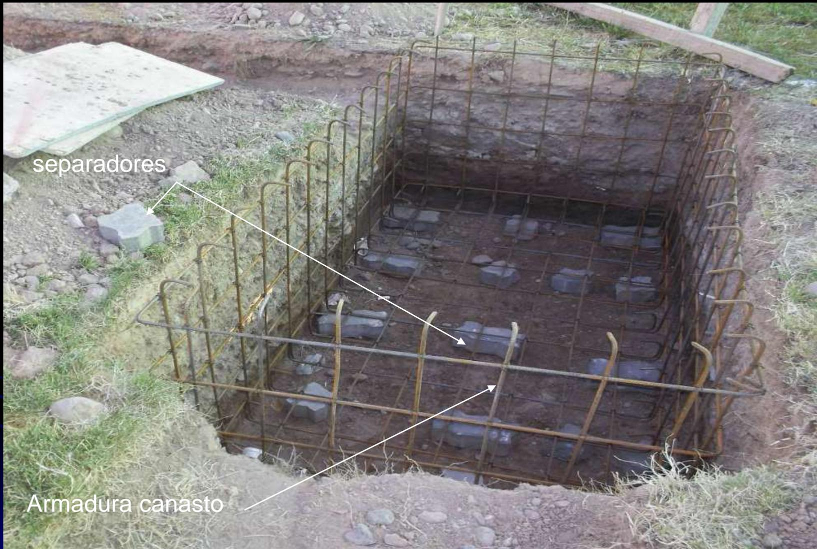
Base aislada, armadura tipo canasto y separadores de hormigón para evitar que la armadura toque el terreno natural y asegurar un recubrimiento mínimo de hormigón en los hierros de base.
