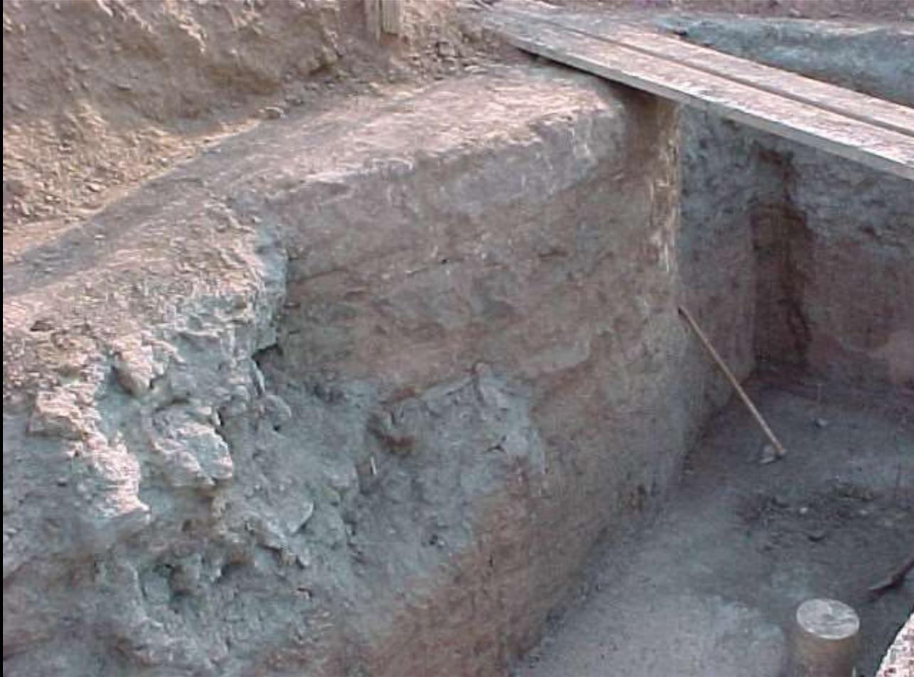
Las excavaciones se pueden realizar en forma manual (pico y pala) y dependiendo del tipo de suelo se respetará el talud máximo natural que el suelo permita. También y para prevenir derrumbes, se “chicotea” el talud del terreno con concreto, con el fin de materializar una pantalla impermeable que evita el “lavado” del terreno.
