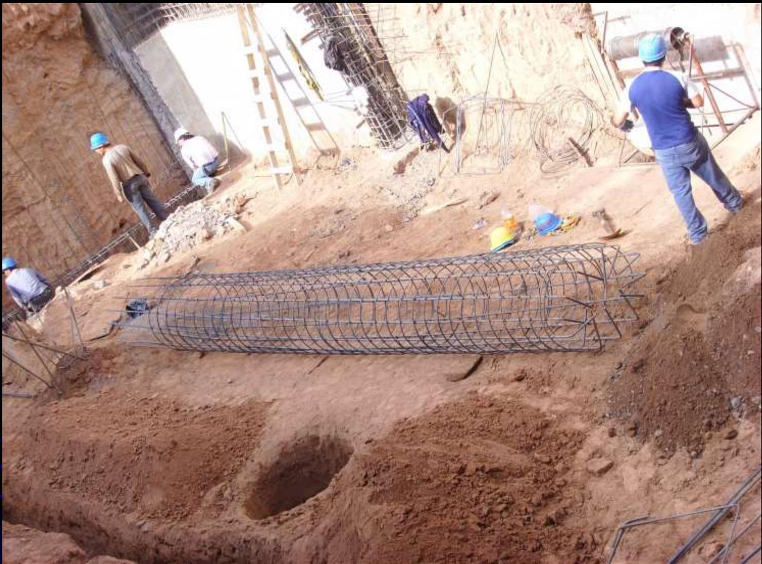
Armadura de pozo de fricción en espera de ser colocada
