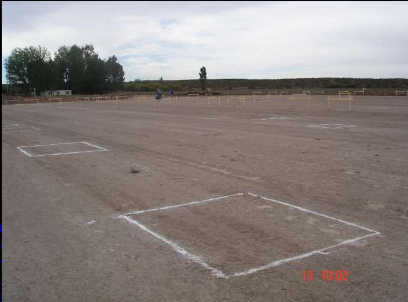
Replanteo de bases aisladas mediante caballetes, preparadas para realizar la excavación.
