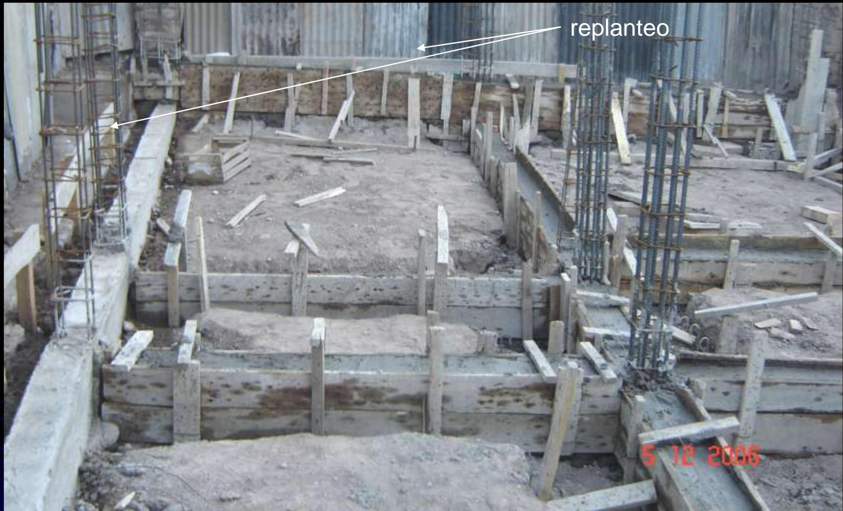
Una vez terminado el llenado de cimientos y bases, se procede a la colocación de armaduras de viga de fundación, encofrado y llenado. El alineamiento de las vigas debe hacerse también con hilos utilizando las marcas realizadas en el replanteo, por lo cual éste debe permanecer confiable hasta esta etapa de trabajo.
