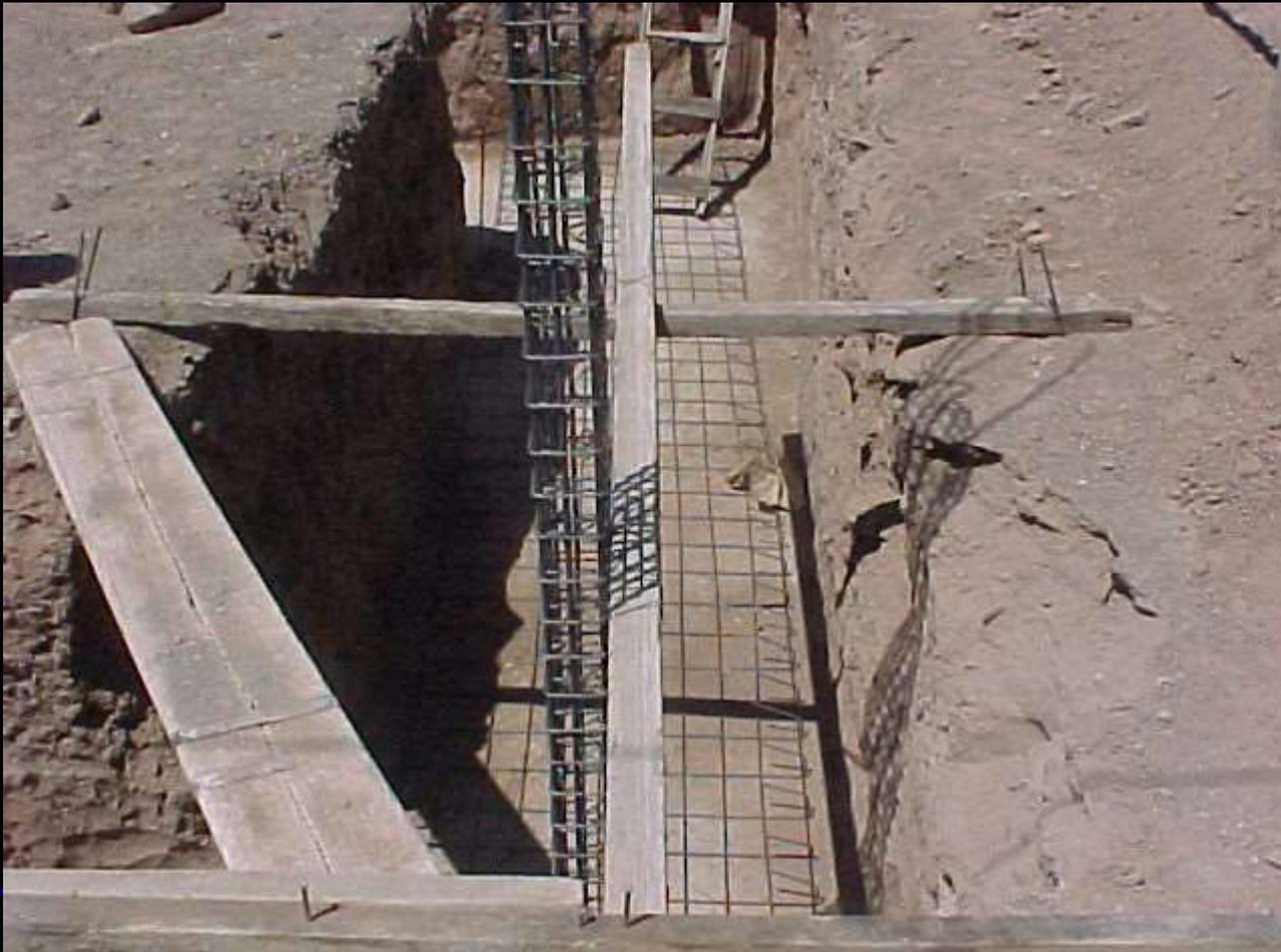
Una vez realizadas las excavaciones, compactado el suelo y realizada la limpieza, se colocan las armaduras de las bases de fundación y se colocan las columnas. Las armaduras de columnas deben arrancar desde el fondo de bases y cimientos, y deben estar posicionadas antes del hormigonado de las fundaciones.
