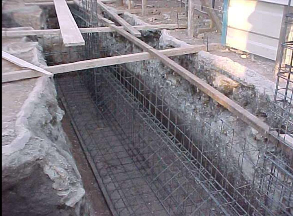
Las zapatas combinadas son un tipo de fundación superficial, la cual se usa en caso de que columnas de una edificación estén separadas por una corta distancia. Las zapatas superficiales que brindan apoyo a más de una columna o a más de un muro son conocidas como bases corridas o zapata continua.
