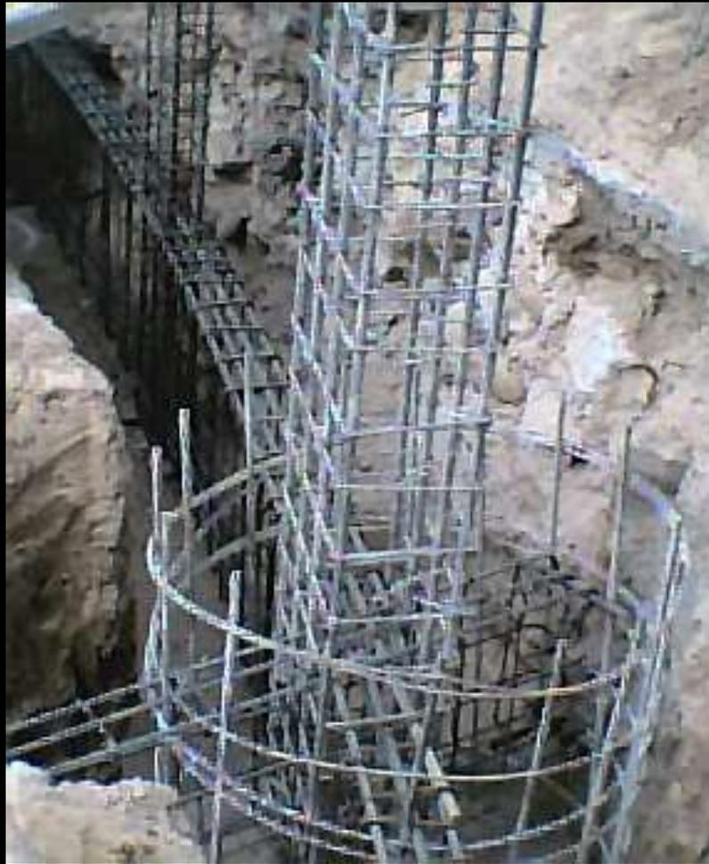
Armadura de pozo de fricción con columna y vigas de fundación colocadas a la espera de ser hormigonada.
