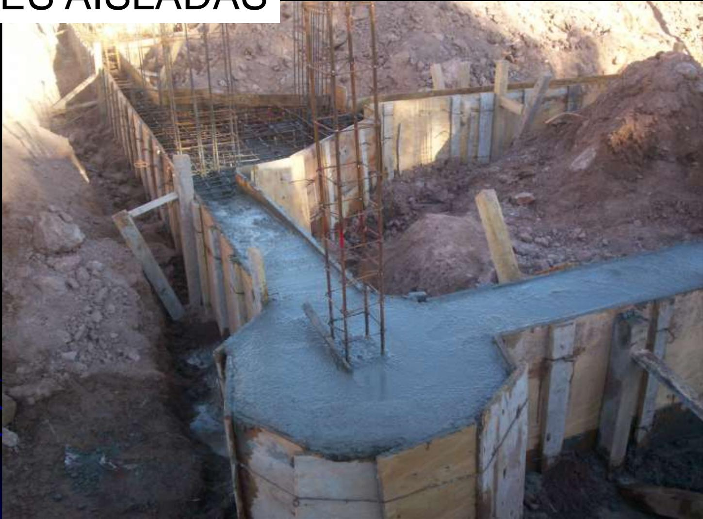
Base aislada, armadura tipo canasto con columna posicionada y alineada.
