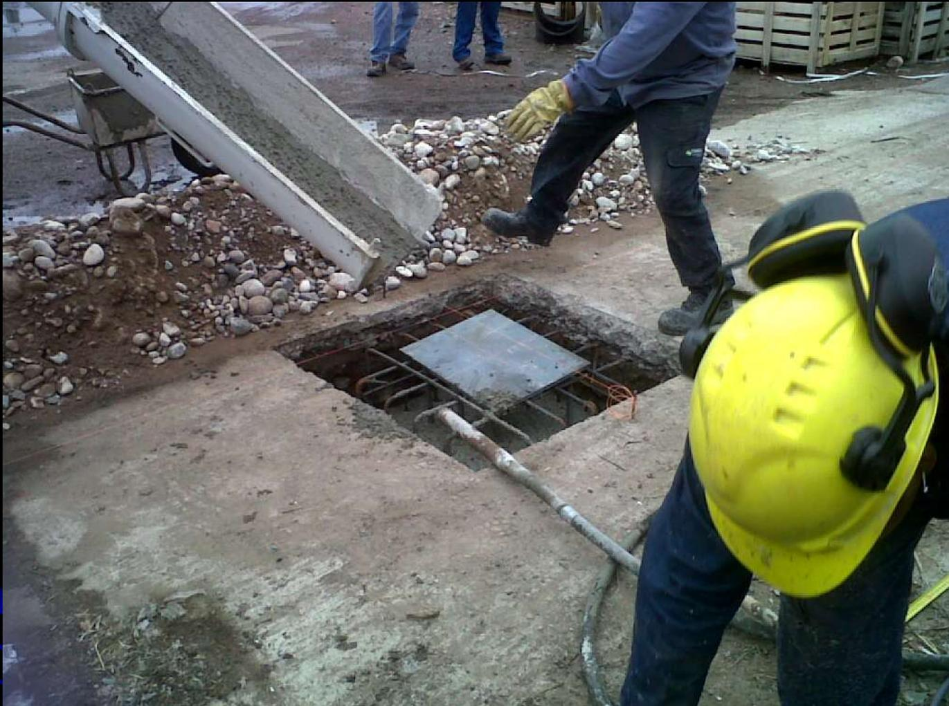
Hormigonado de una base aislada, armadura tipo canasto, con una platina metálica en la parte superior para posterior colocación de una columna metálica soldada.
