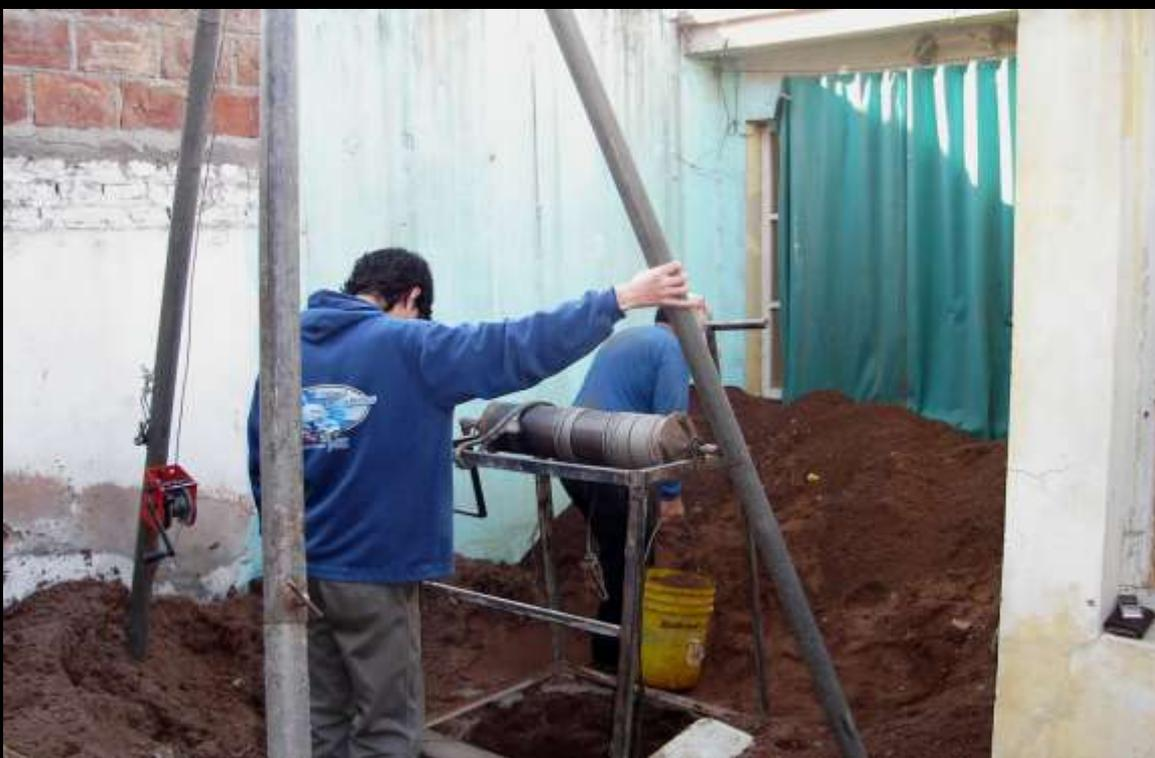
Excavación de pozos con un torno.
