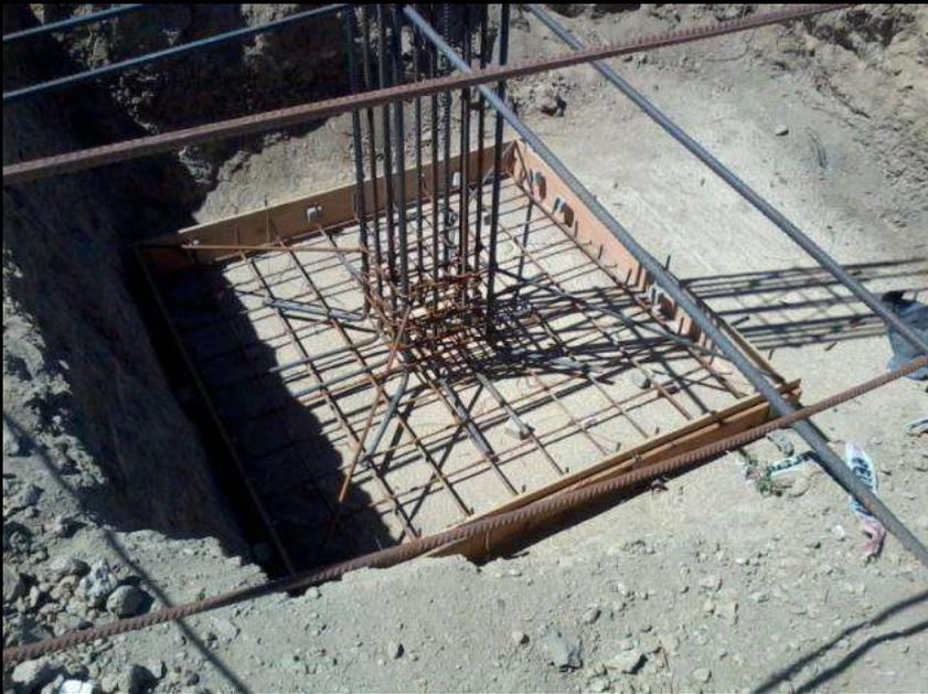
Base aislada, armadura tipo parrilla, con columna posicionada y alineada. Base encofrada y hormigonada
