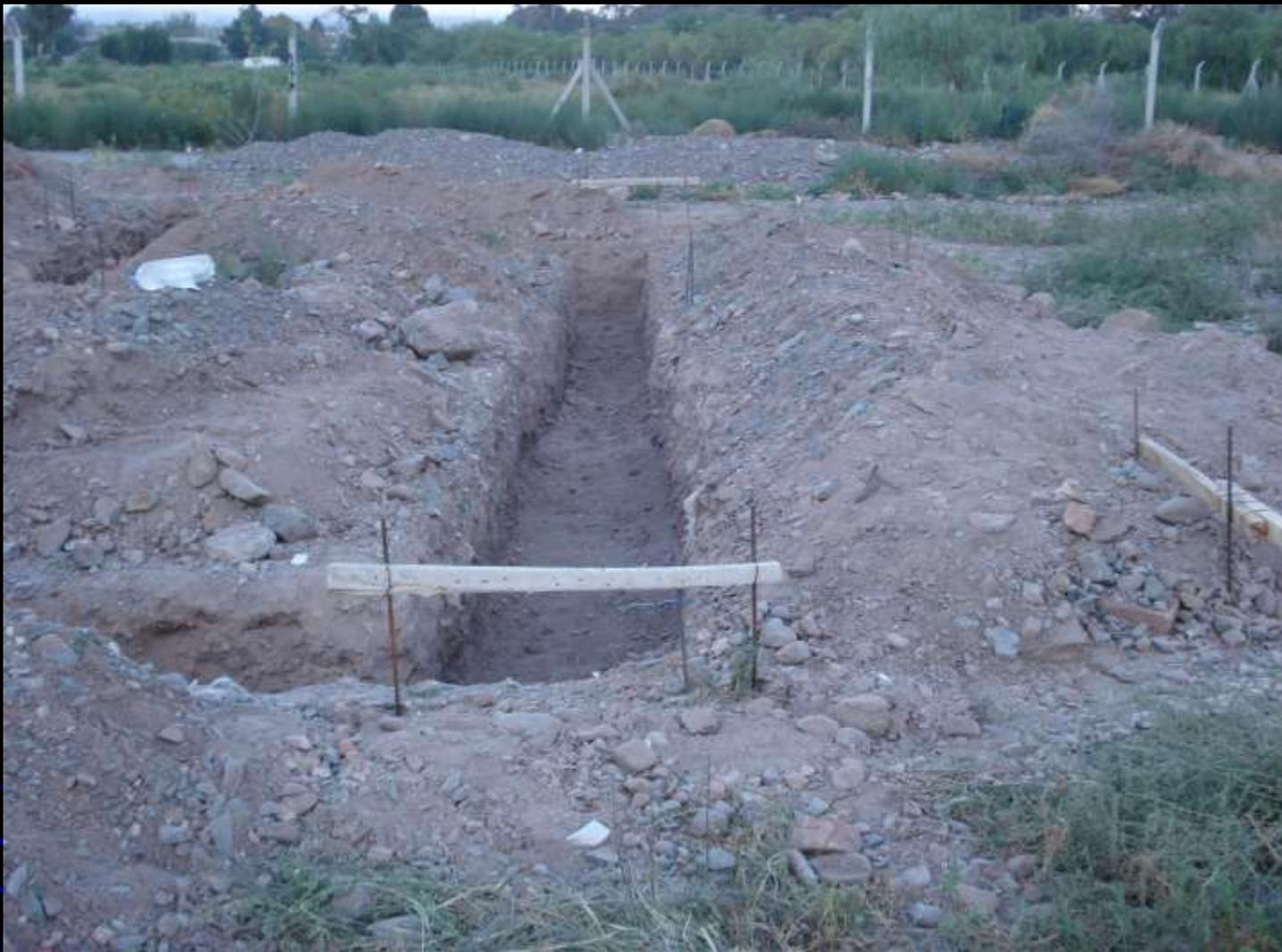
Excavación de cimientos, tomando como referencia lo marcado en el replanteo, en este caso caballetes, separados por lo menos 1 m de la zona de excavación para asegurar la permanencia de las mediciones en el tiempo.
