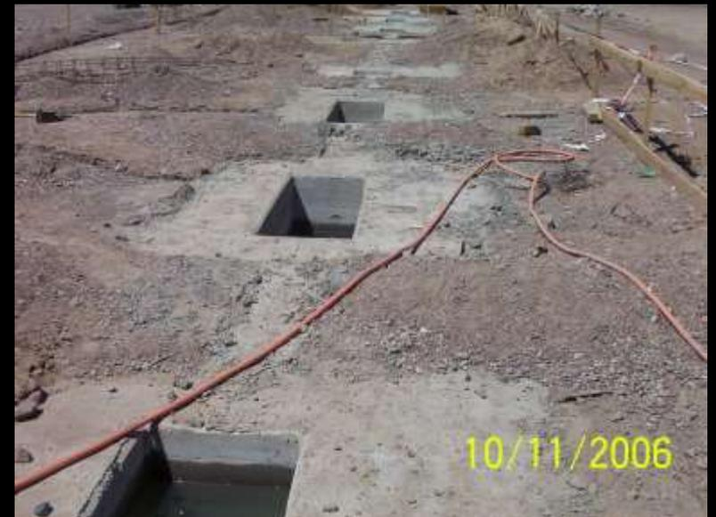
Bases hormigonadas, a la espera de colocación de columnas prefabricadas
