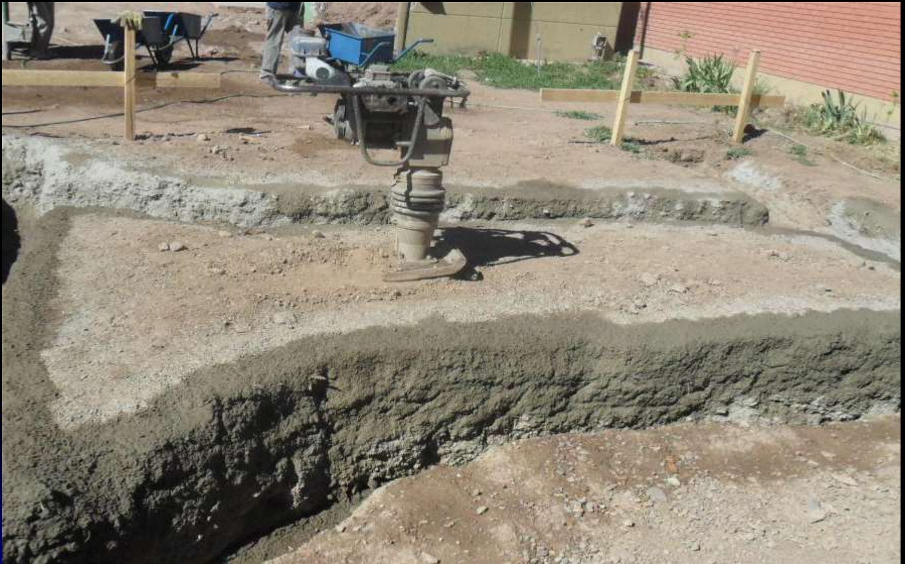
Para prevenir derrumbes, se “chicotea” el talud del terreno con concreto, con el fin de materializar una pantalla impermeable que evita el “lavado” del terreno.
