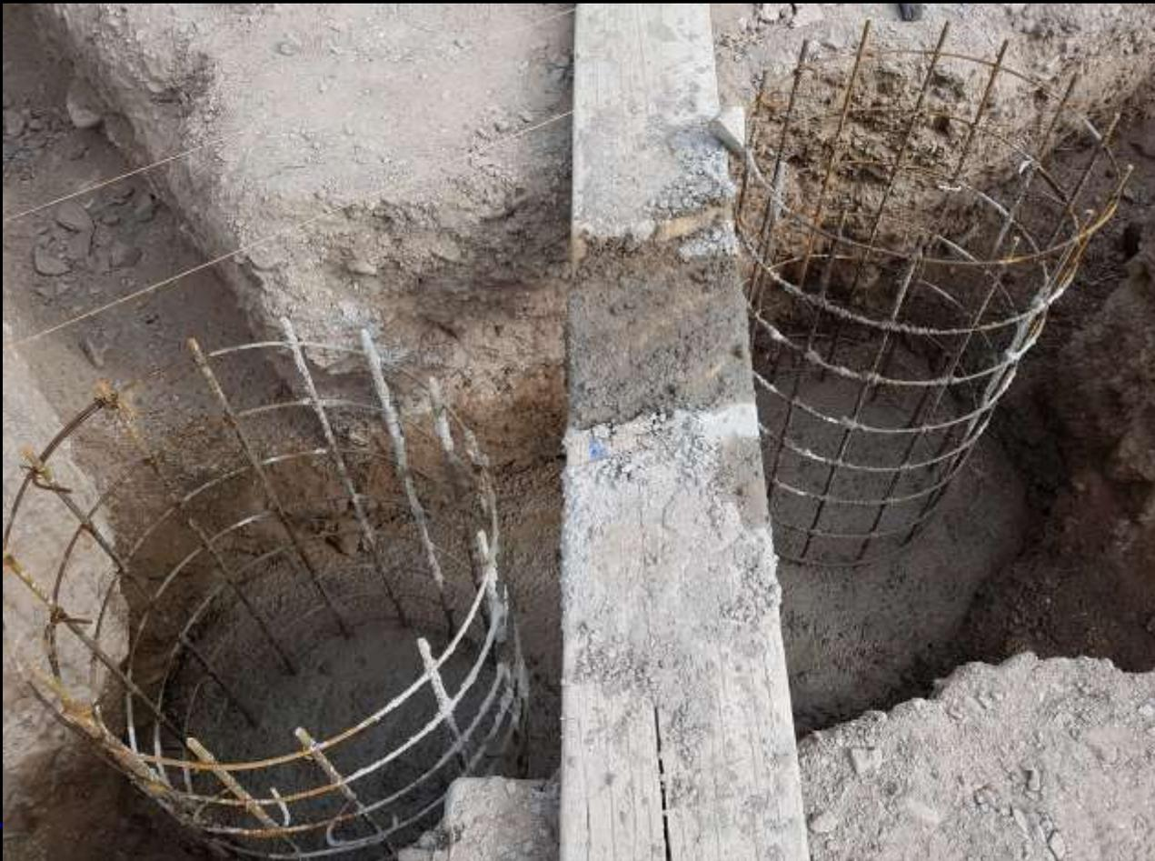
Armadura del canasto de pozos de fricción a la espera de colocar las columnas.
