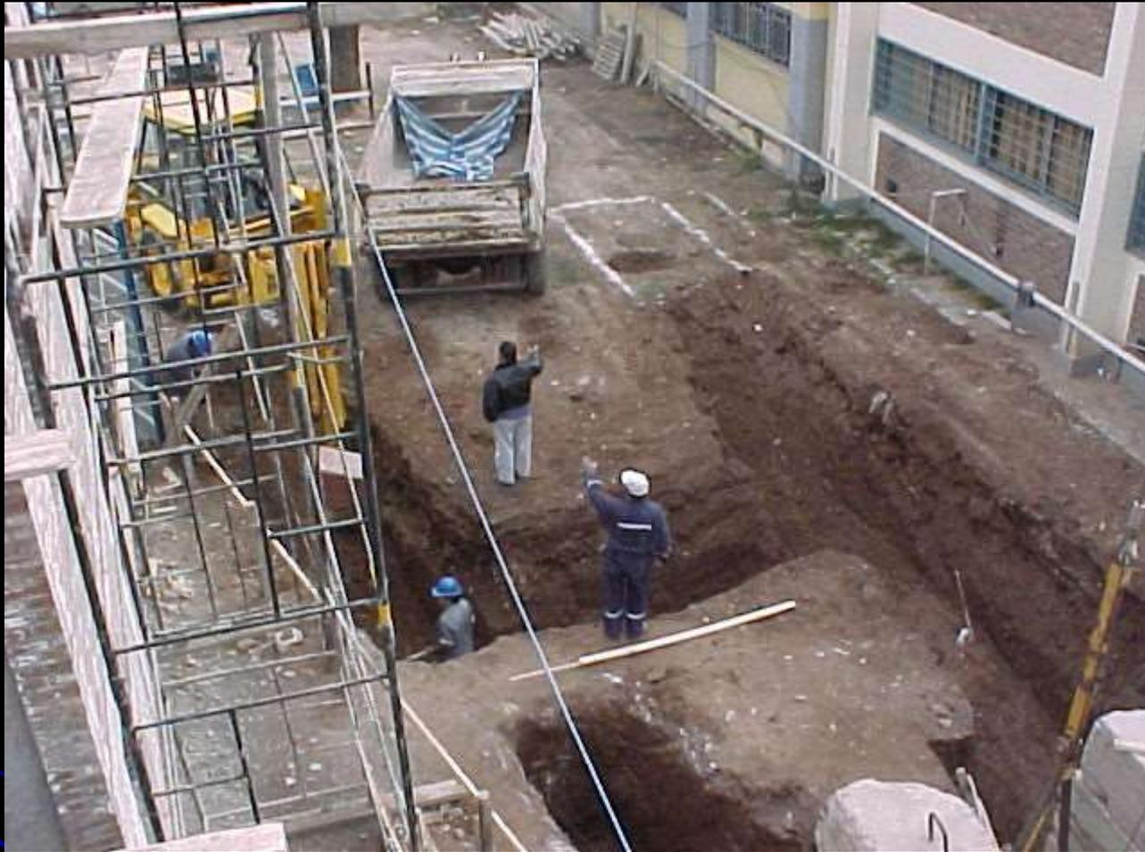
Si el tipo de fundaciones y las dimensiones de la obra lo permiten, las excavaciones pueden ser realizadas por medios mecánicos (retroexcavadora y camión en este caso) lo cual incrementa notablemente el rendimiento de las tareas y acorta los plazos de obra.
