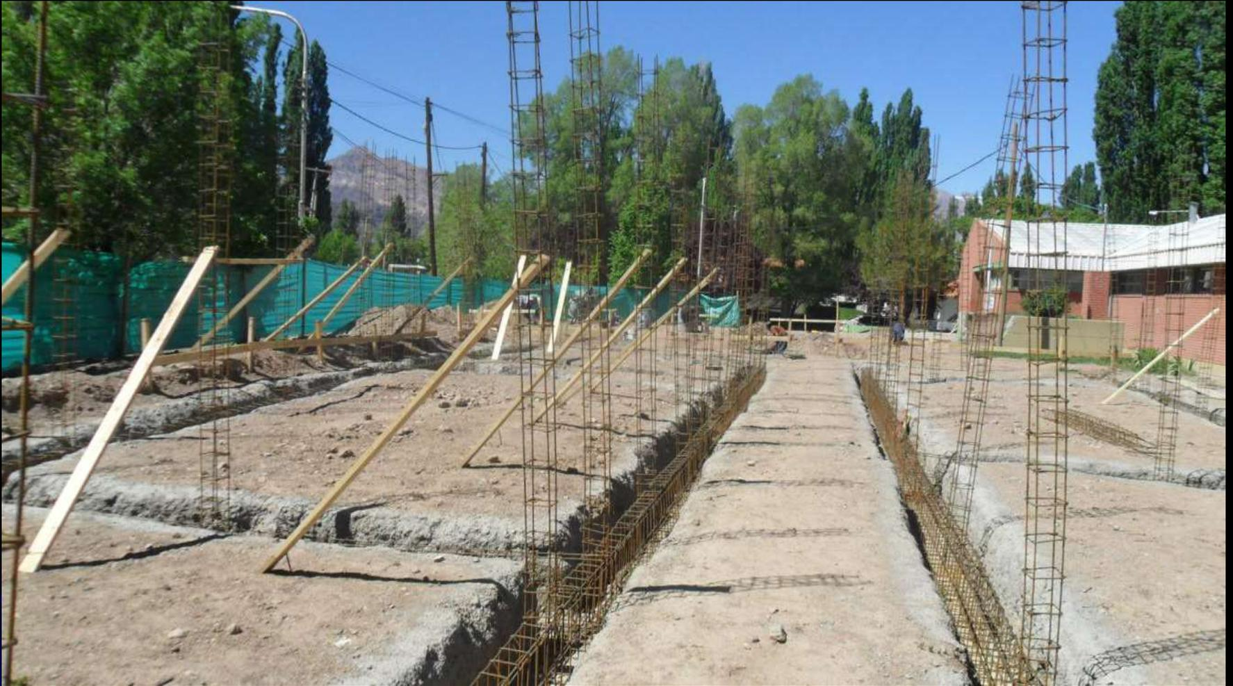
Una vez realizadas las excavaciones, compactado el suelo y realizada la limpieza, se colocan las armaduras de las bases de fundación y se colocan las columnas. Las armaduras de columnas deben arrancar desde el fondo de bases y cimientos, y deben estar posicionadas antes del hormigonado de las fundaciones.
