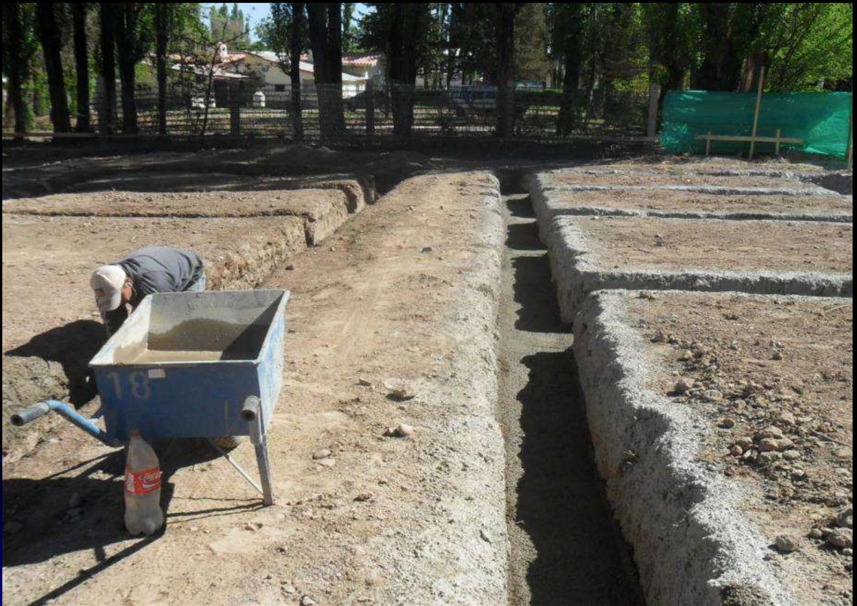
Para prevenir derrumbes, se “chicotea” el talud del terreno con concreto, con el fin de materializar una pantalla impermeable que evita el “lavado” del terreno.
