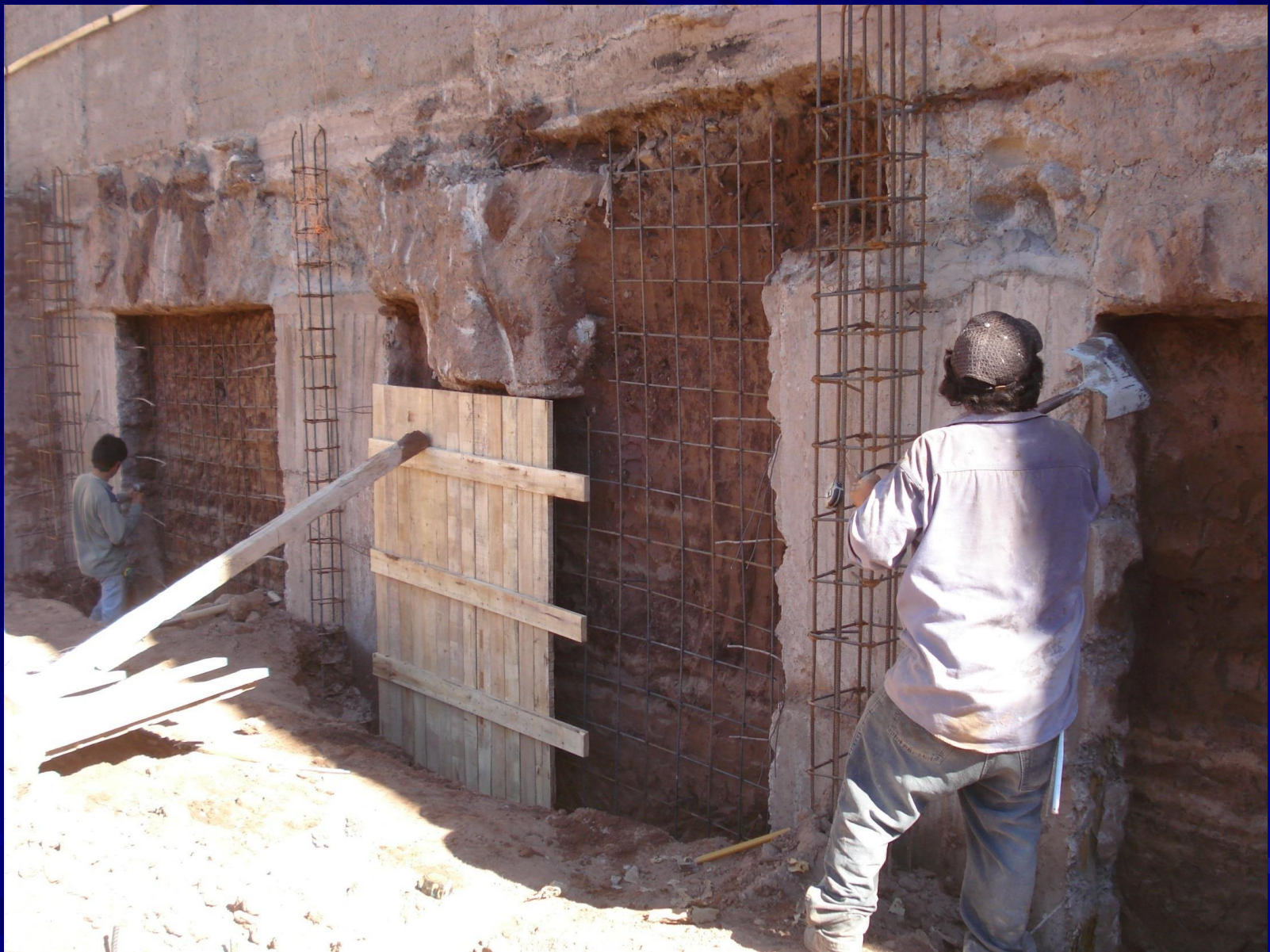
Limpieza y colocación de encofrados para proceder al hormigonado
