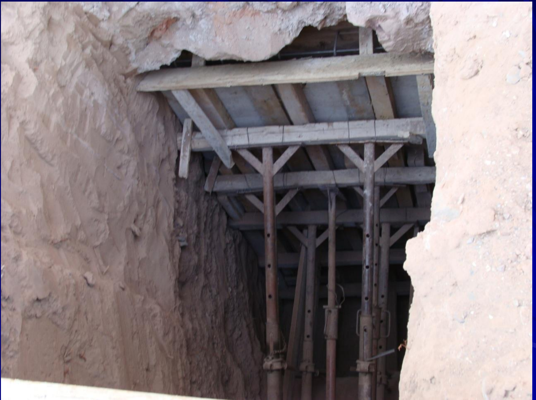
Vista superior del encofrado y apuntalamiento de submuración por pozo
