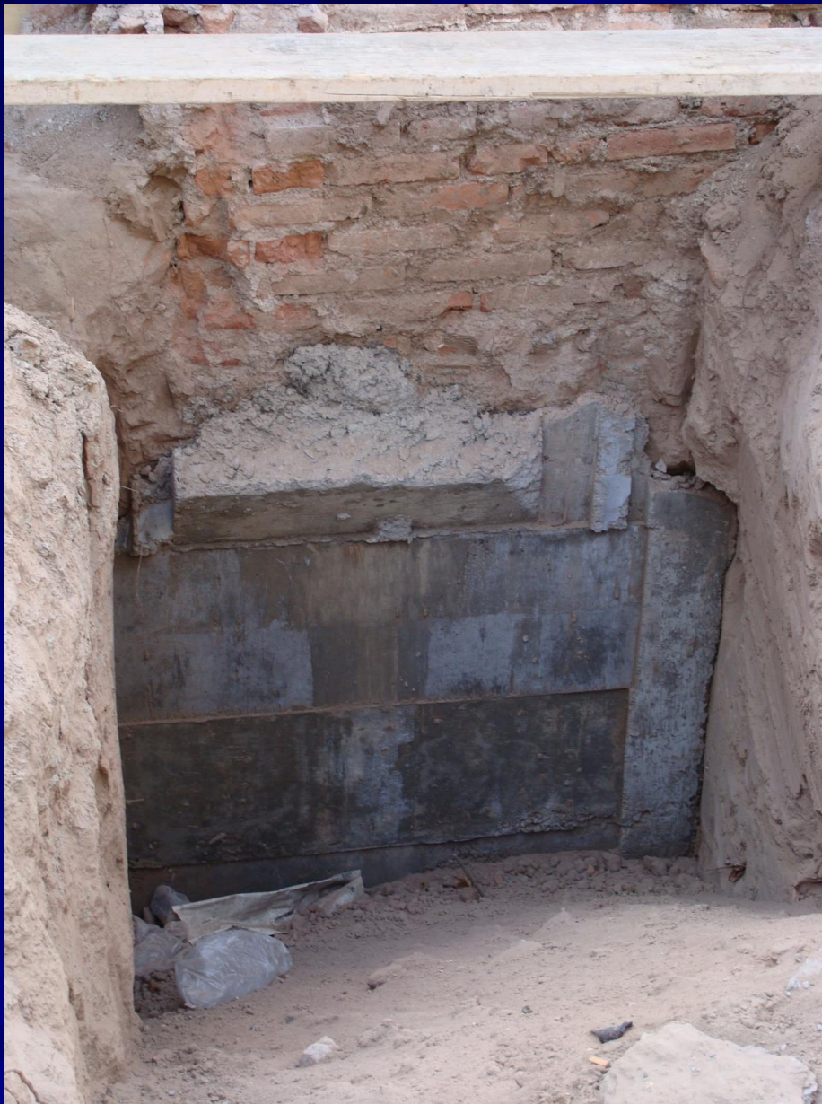
La submuración finalizada
