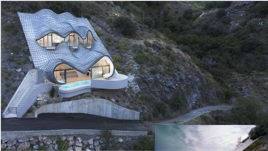
Casa Acanalado, Gil Bartolomé arqs.
