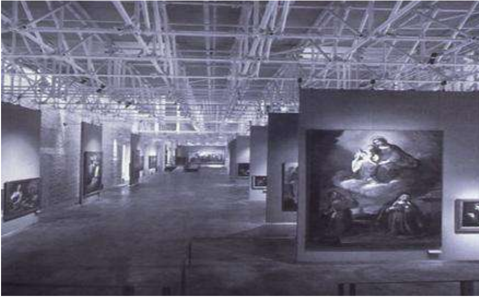
Fig. 6.2 Estructura espacial para integración de instalaciones.
