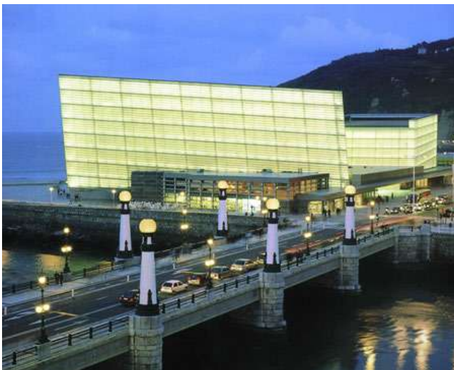
Fig. 3.26 Espacios exteriores próximos al edificio Kursal de San Sebas- tián.
