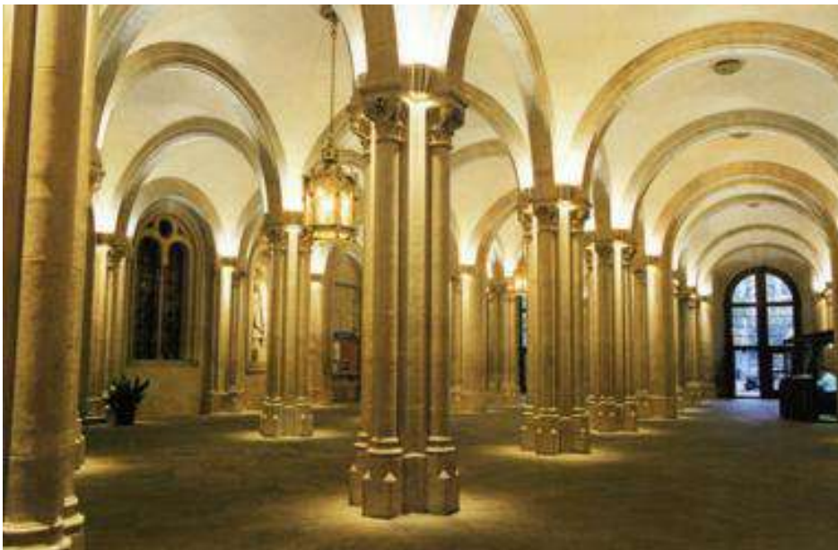
Fig. 6.3 Instalación de luminarias diseñadas especialmente para la ubicación en los capiteles.
