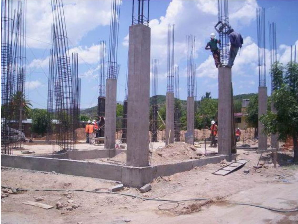
Figura 13: Columnas de hormigón armado
