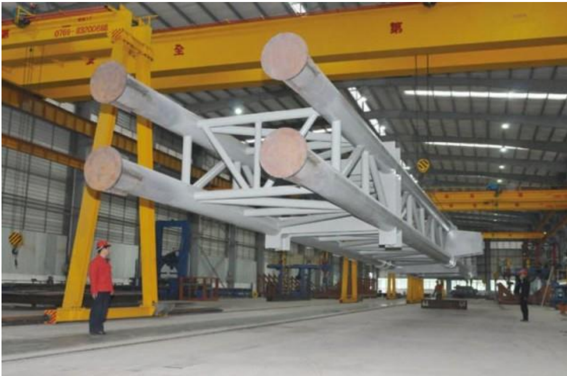
Figura 3: Columna armada de acero
