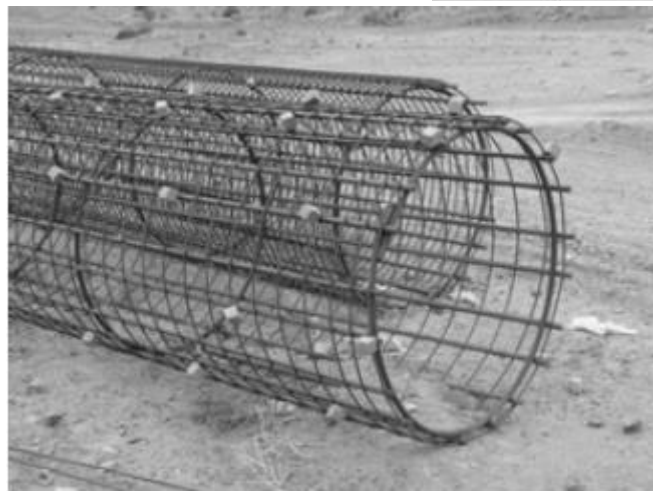
Figura 24: pilas de hormigón armado
