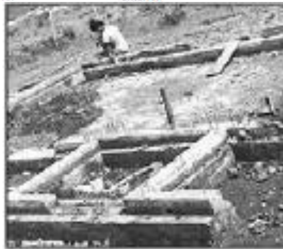
Figura 3: cimientos de hormigón ciclópeo
