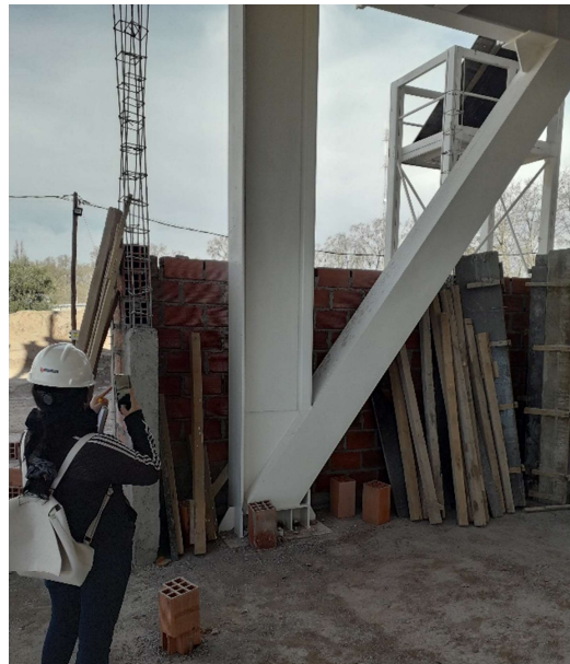
Vinculación triangulación con losa
