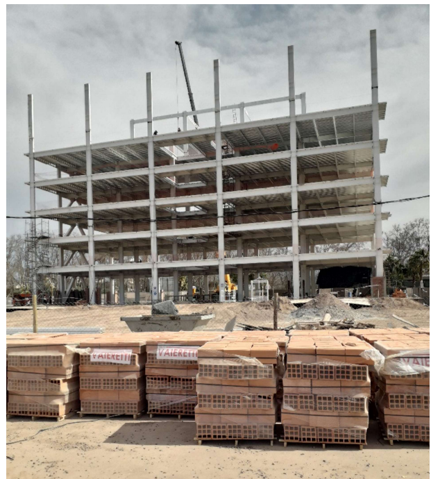
Edificio en construcción
