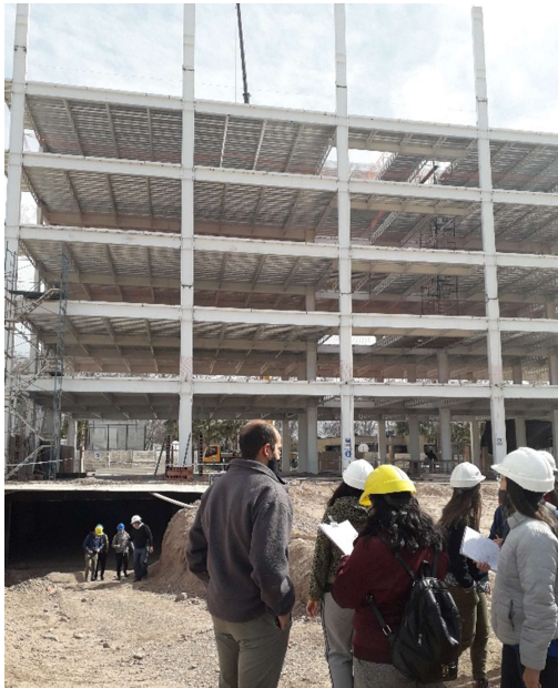
Esqueleto estructural y subsuelo
