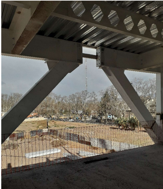
Detalle triangulaciones "K"
