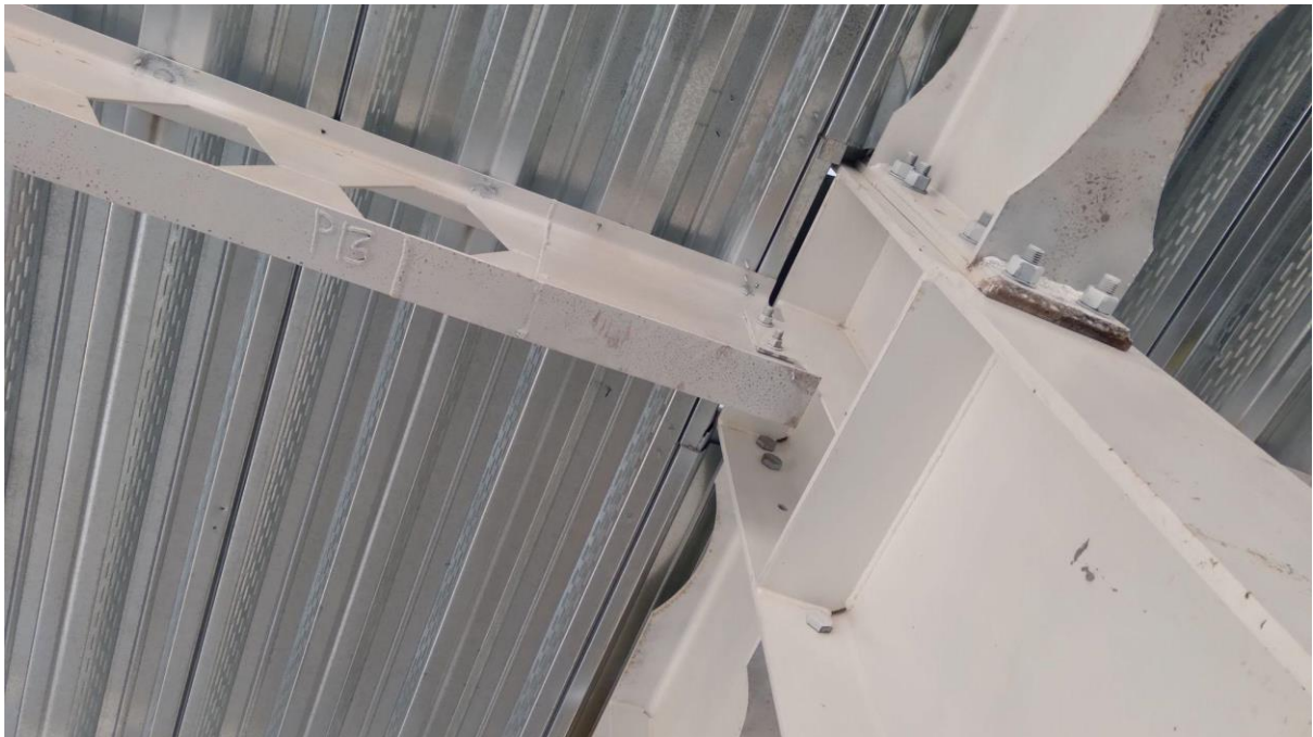
Unión de vigas con columnas
