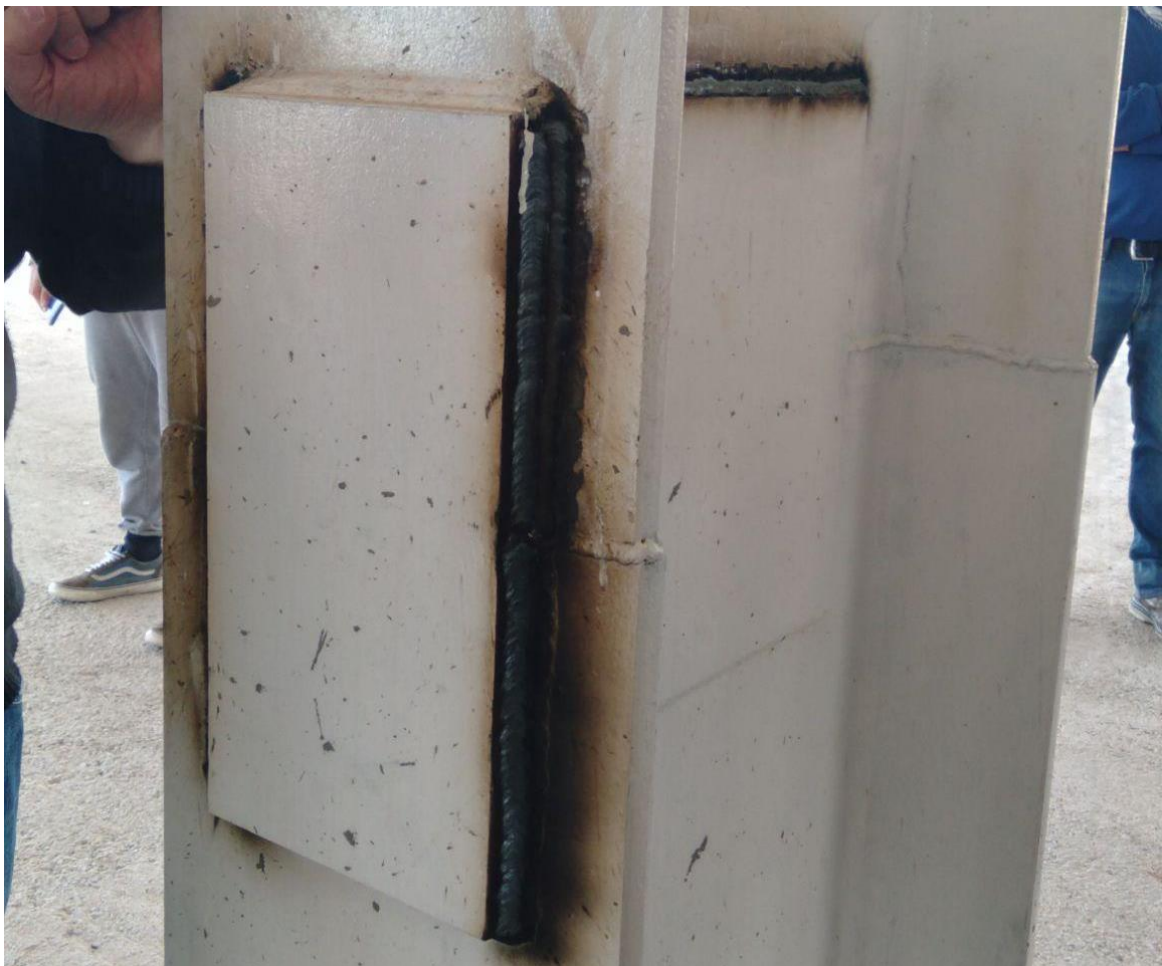
Unión entre columnas
