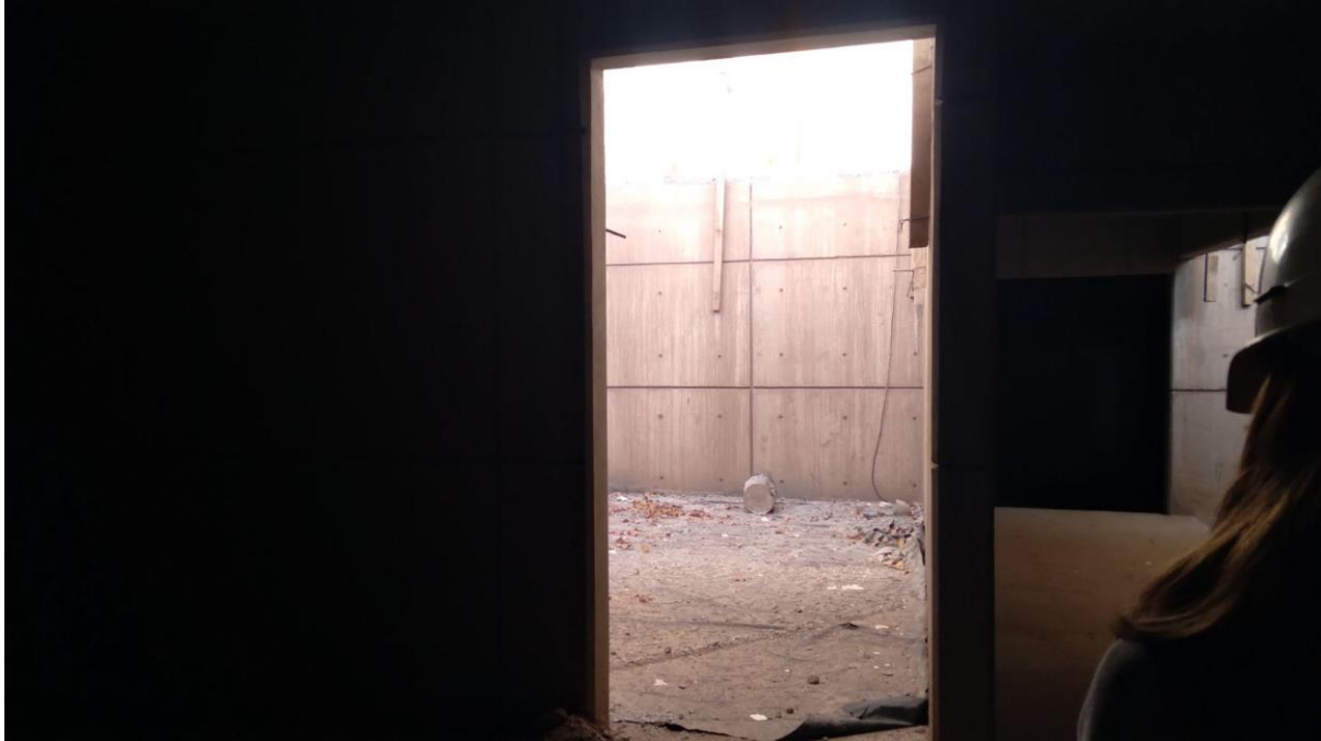
Caja de escaleras
