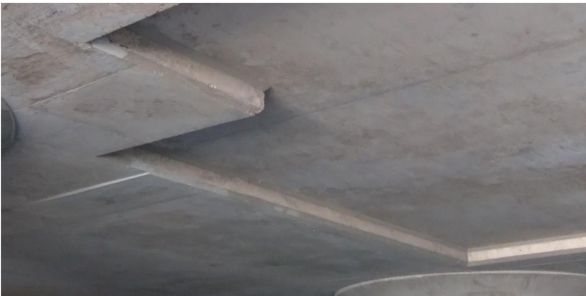
Cambio de nivel en losa
