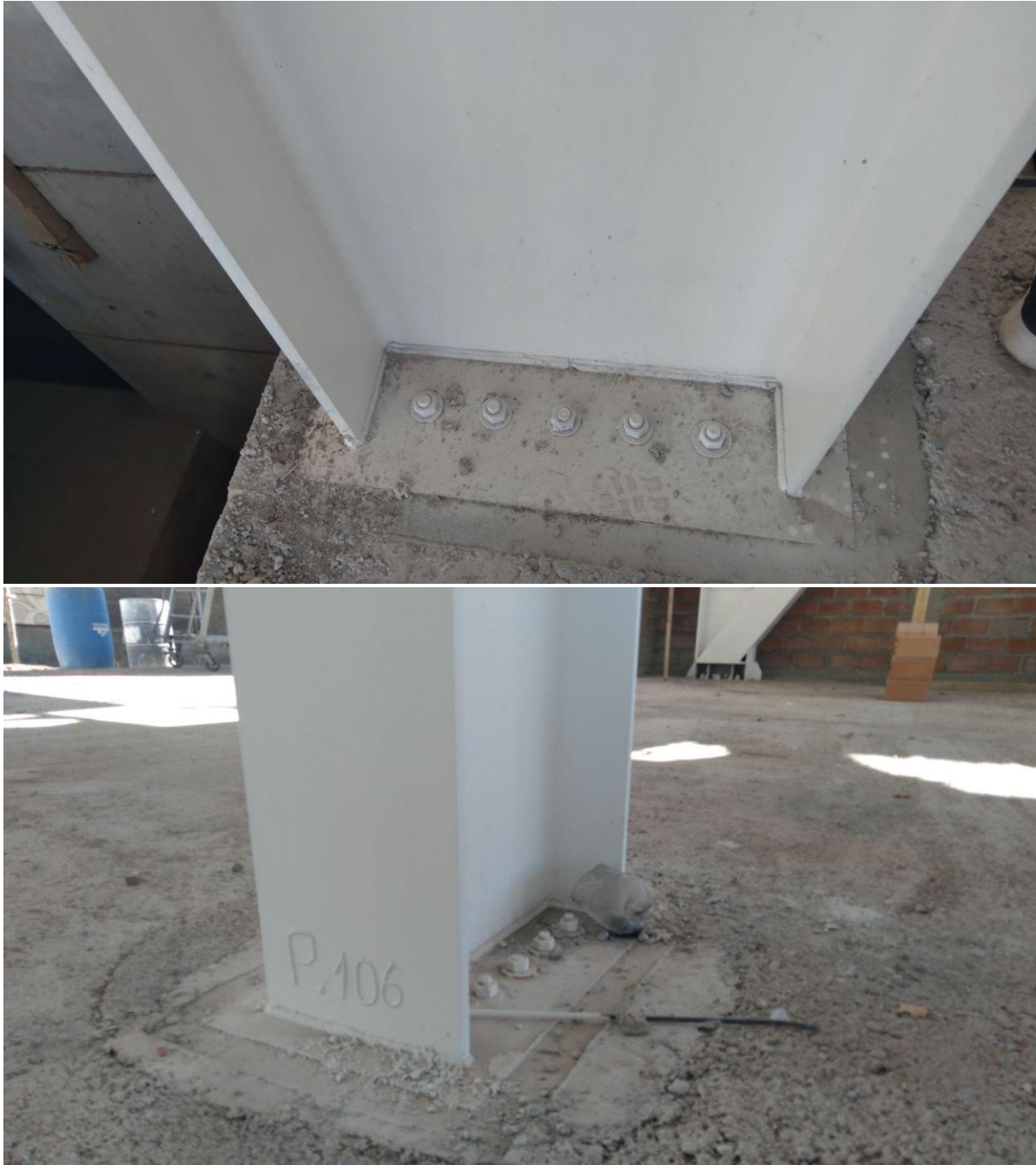
Unión de estructura metálica con estructura de hormigón
