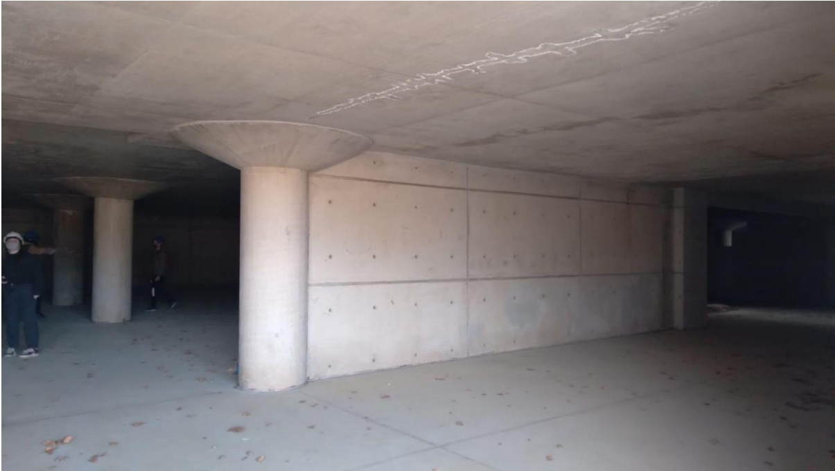
Columna junto a tabique
