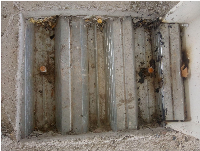
Figura 9: pernos conectores “Nelson”
