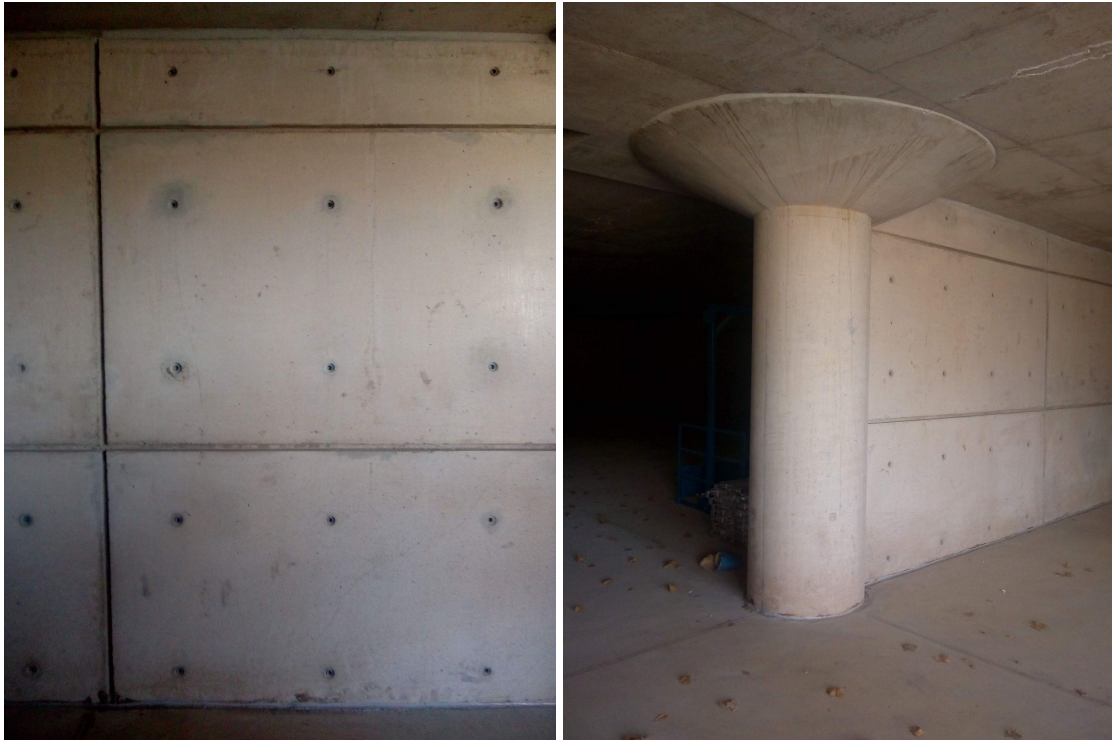
Figura 2 y 3: subsuelo, columnas
