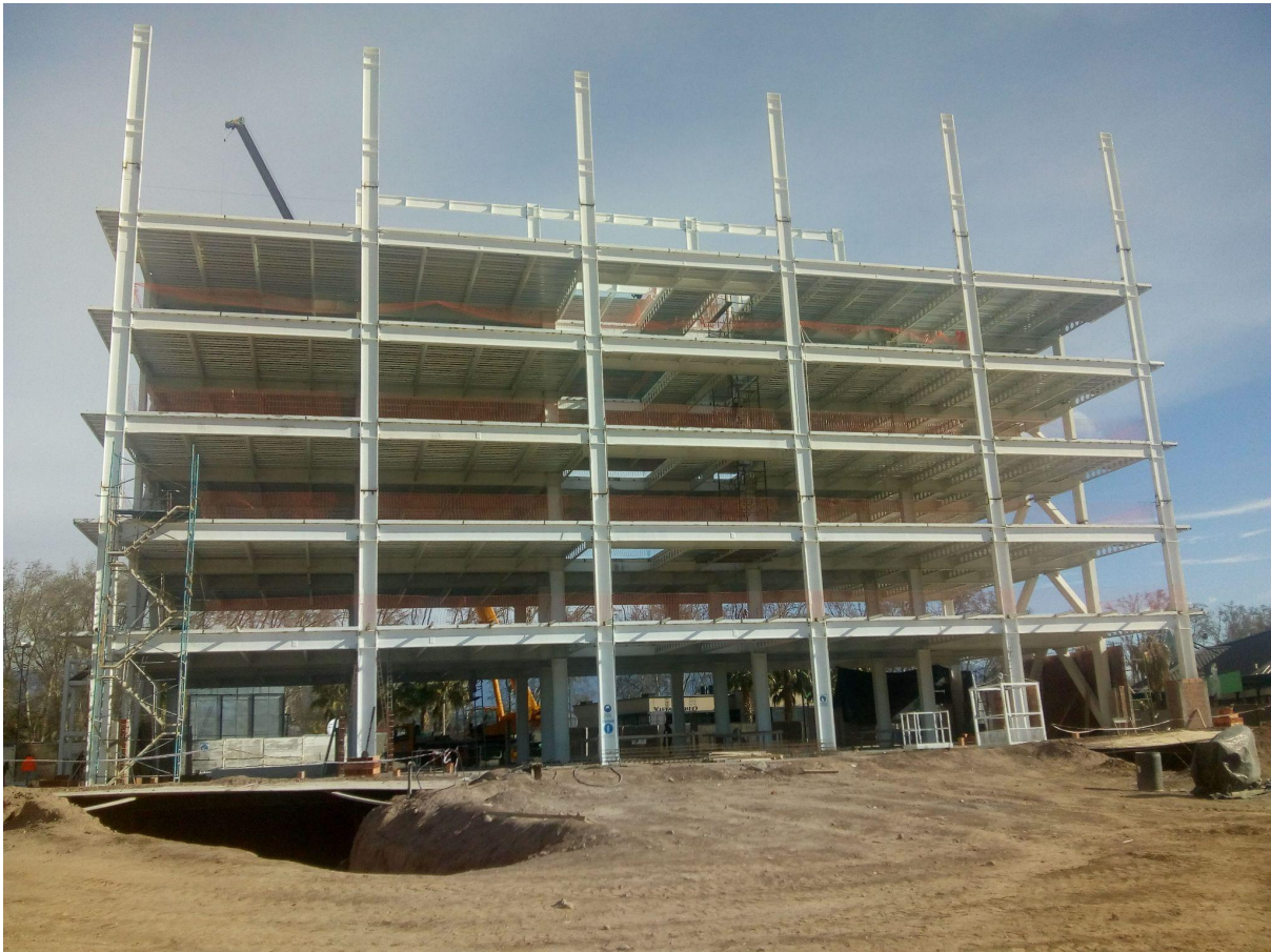
Figura 1: Edificio Alvear en etapa de obra
