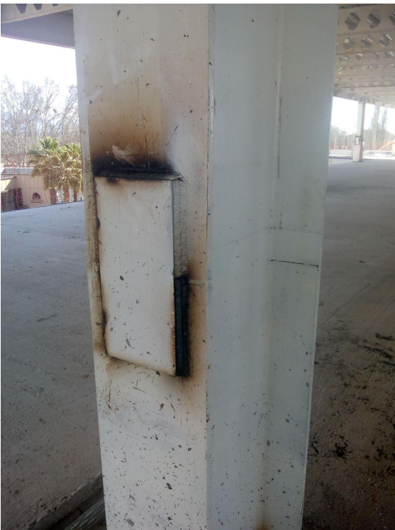
Figura 7: unión columnas por soldadura
