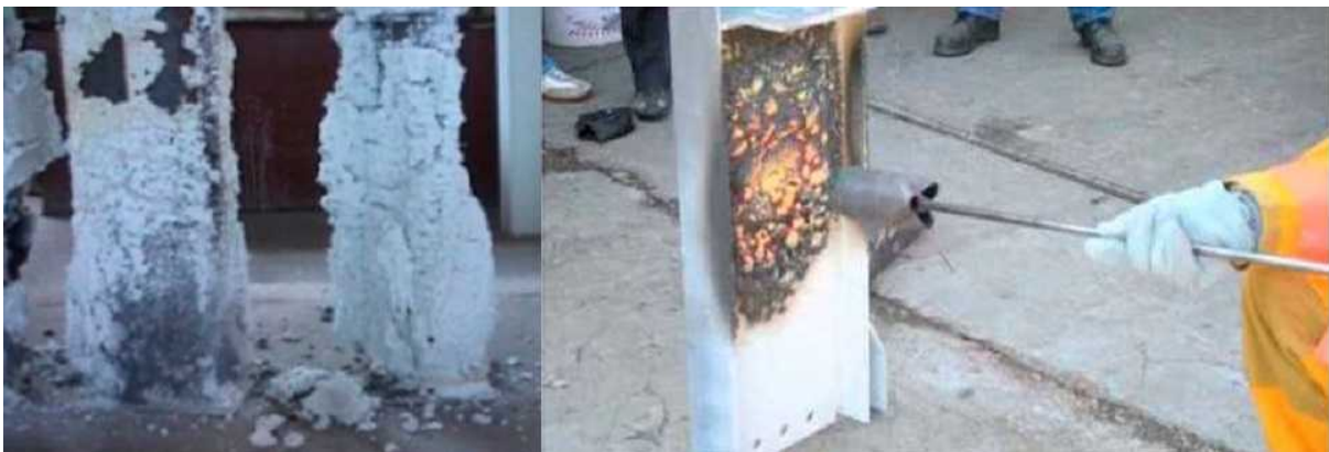
Figura 10: ejemplo de la aplicación de la pintura ignífuga
