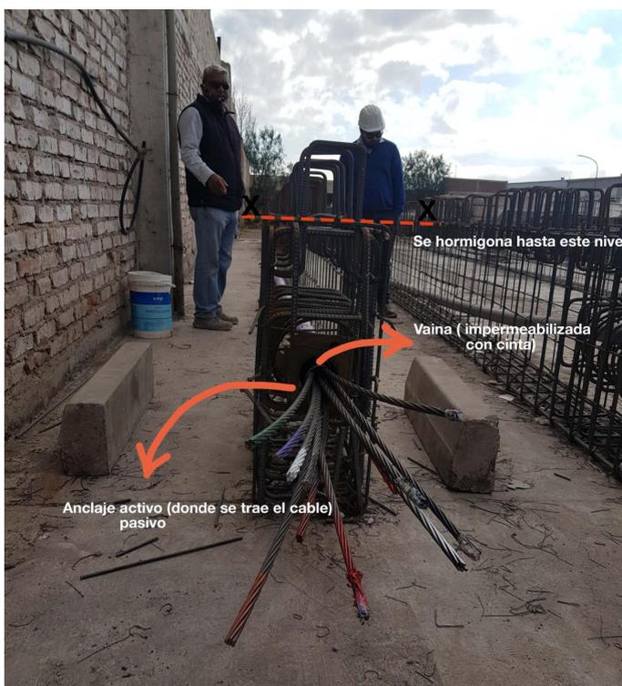
En la planta se nos muestra una viga ya armada, pero sin hormigonar porque esa parte se realiza en la obra.
