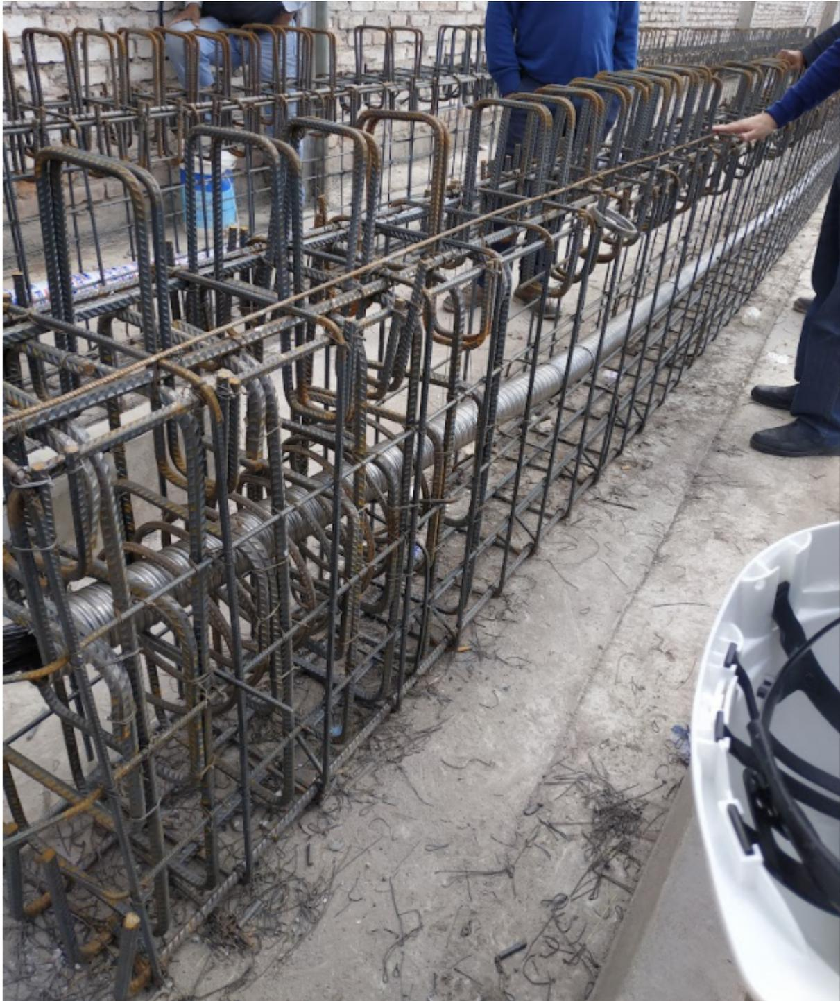
*Nivel de hormigonado y hierros de conexión a corte*
