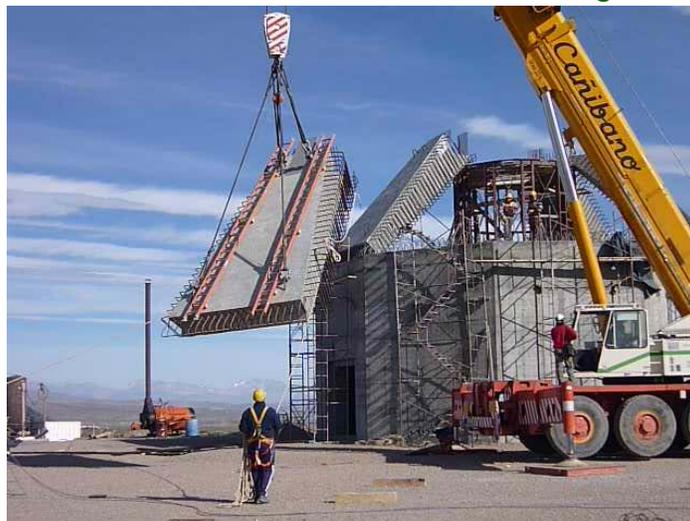
Montaje de dovelas prefabricadas y ensamblado en obra
