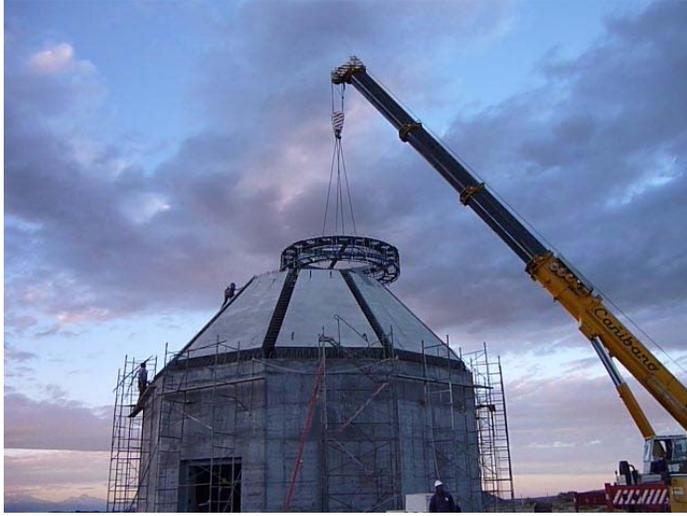
Montaje del anillo superior para vincular las dovelas prefabricadas
