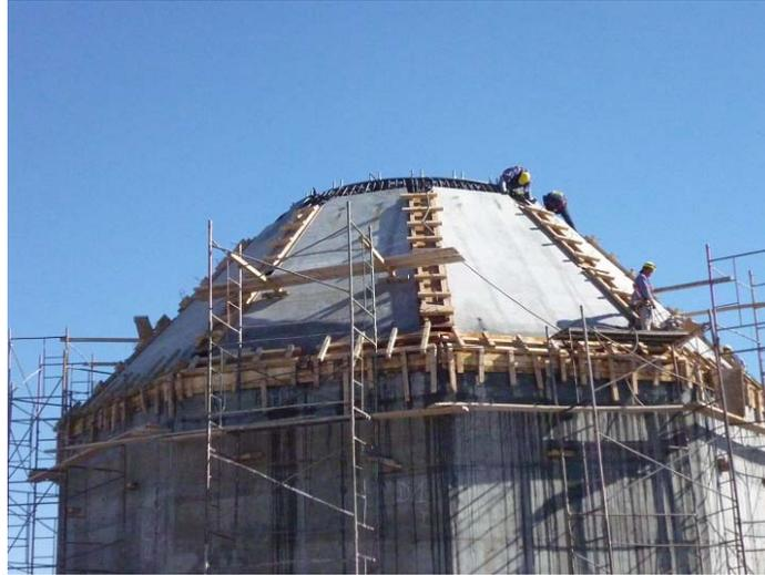
Encofrado de vigas y anillo de vinculación de dovelas
