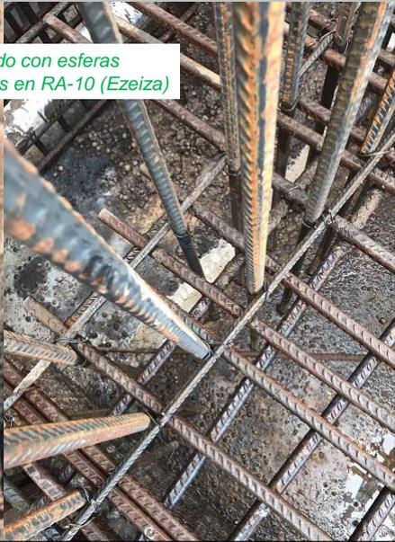
*Hormigón pesado con esferas "perdigones" metálicos en RA-10 (Ezeiza)*
