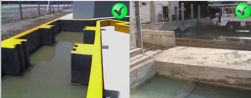
*Pileta de reciclado de agua de lavado de equipos*      *Instalaciones de para el lavado de equipos con sedimentadores*
