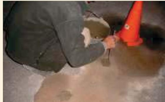
➤ Reparación de huecos dejado por testigos con grout cementicio.
