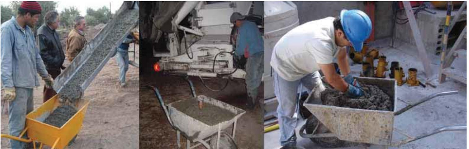
Figura 1 - Muestreo del hormigón fresco y homogeneización a pala
