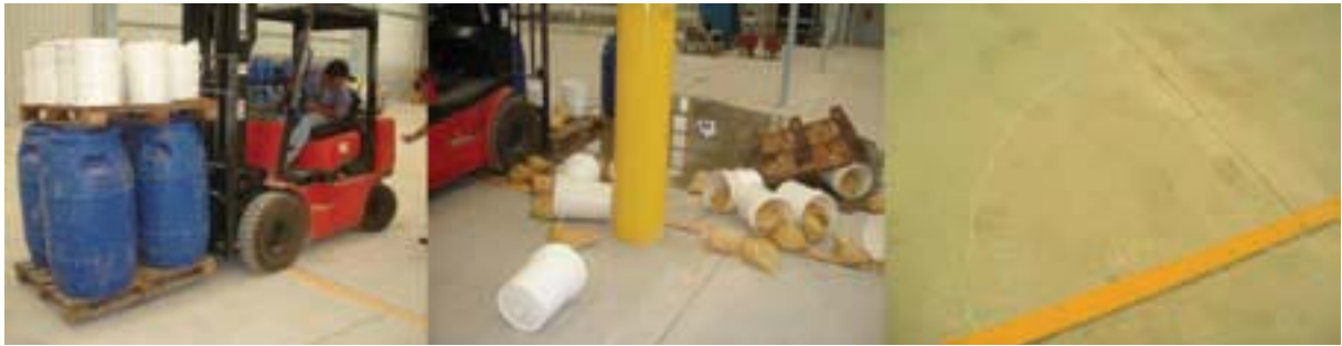
1. Circulación de montacargas en piso industrial y problemas ocasionados por el alabeo, incluyendo fisura típica de esquina
