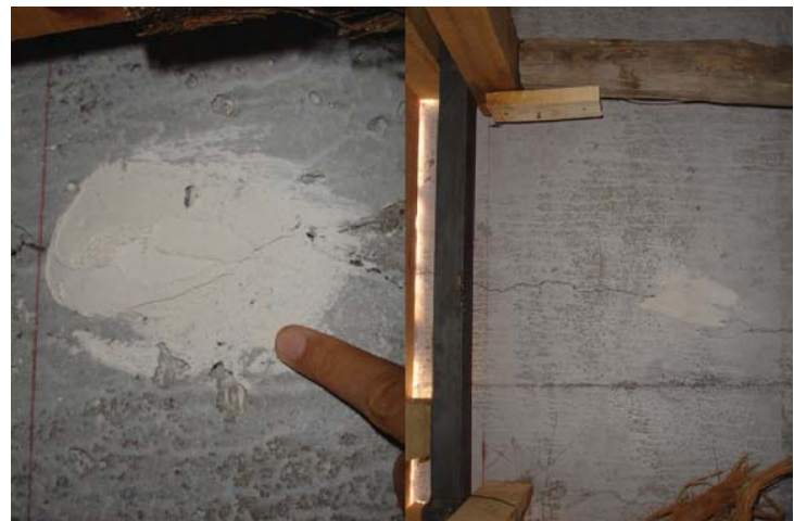
➤ Figura 3. Testigos de yeso para seguimiento cualitativo
