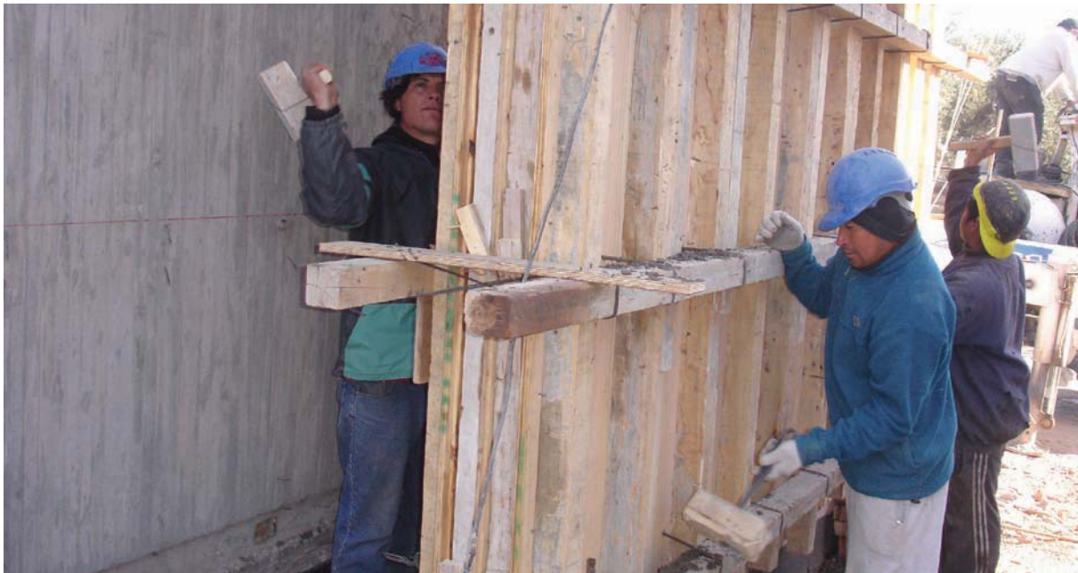
▲ Figura 2. Consolidación mediante golpes de martillos de goma y madera
