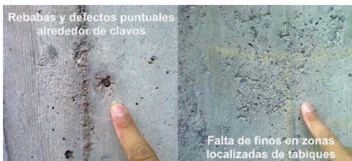
Figura 6 - Defectos puntuales de superficies vistas
