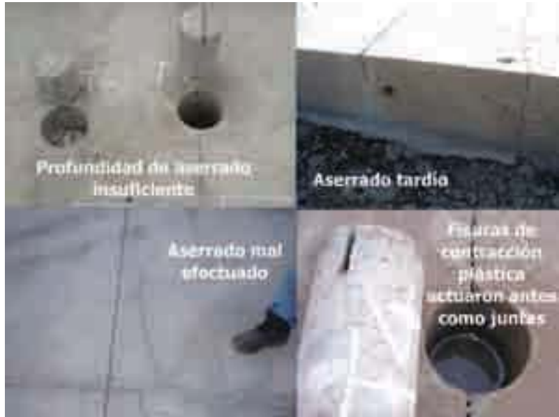
FIGURA 2.3 - Metodología ineficaz para materializar las juntas
