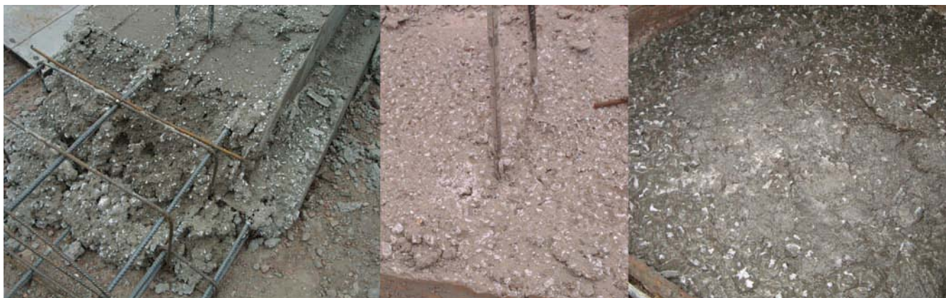
▲ Figura 4 - Eflorescencias de carbonato de calcio que aparecieron el mismo día del colado
