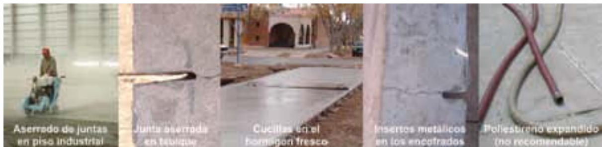
2 Metodologías de materialización de juntas de contracción
