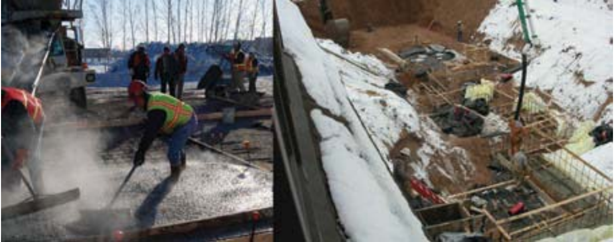
▲ Técnicas constructivas en tiempo frío
