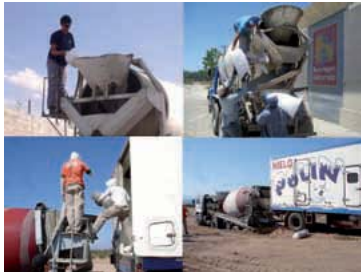
F.2 Reducción de la temperatura inicial empleando hielo
