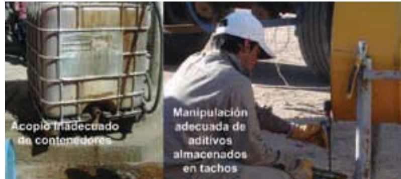
Figura 1 - Acopio de aditivos en obra en contenedores y tachos
