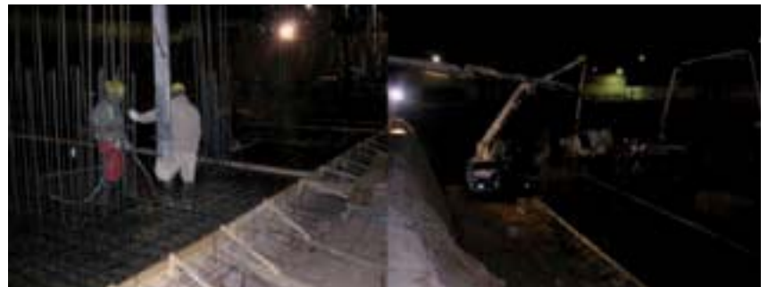
F.6. Hormigonado nocturno en tiempo caluroso
