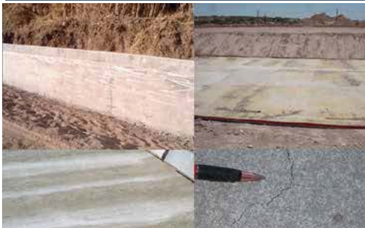
F5 Incorrecta aplicación de membranas de curado
