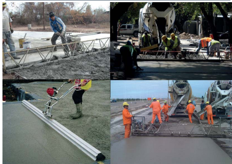
F6 Reglas vibratorias empleadas en pavimentos y losas
