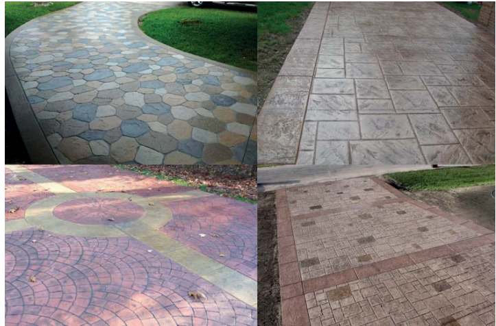
F.8 Pavimentos con el sistema Lithocrete
