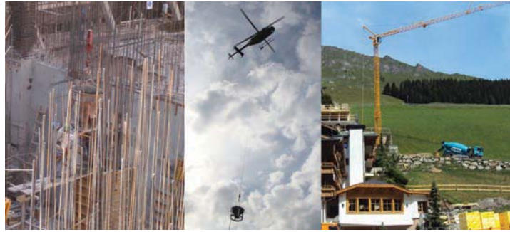
↗ F3: Descarga con baldes de hormigonado
