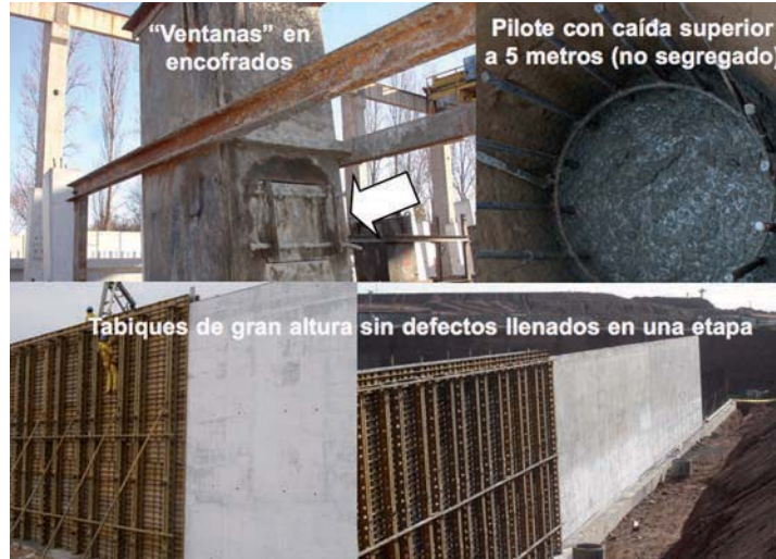
▲ F8: Alturas de caída de hormigonado
