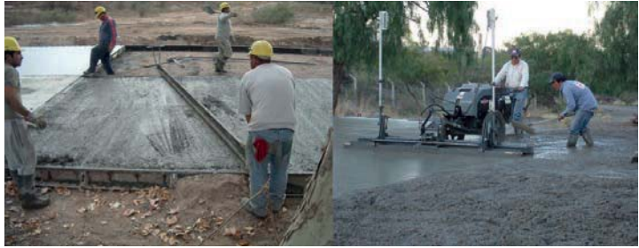
F.3 Aplanado o fratachado preliminar
