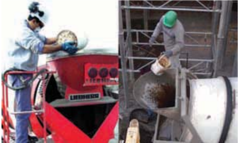
Figura 3 - Incorporación de aditivos superfluidificantes en obra
