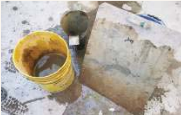
↗ Humedecimiento con agua (no excesiva) de la base y el cono
