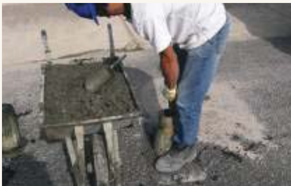
↗ Compactación de la primera capa
