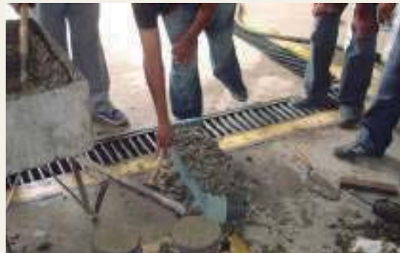
⤴ Golpes con martillo de goma después del varillado de cada capa
