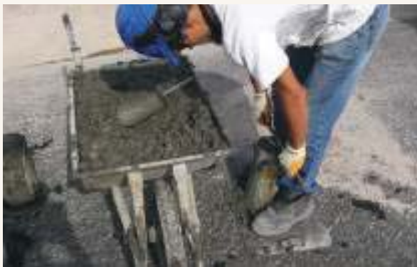
↗ Enrase superior y remoción de hormigón sobrante
