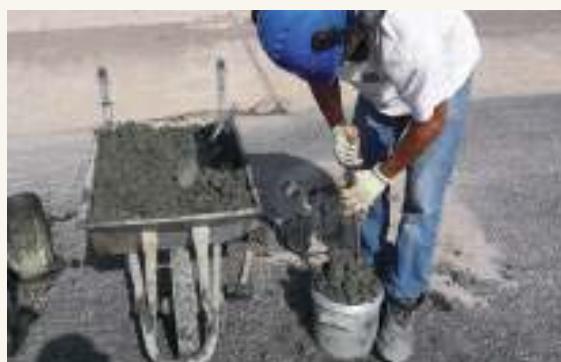
➤ Compactación de la última capa con hormigón sobrante
