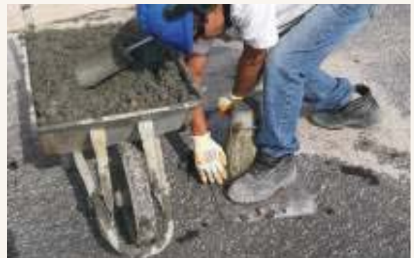
↗ Limpieza de hormigón sobrante de la base y sujeción firme del cono
