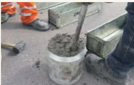
➤ Moldeo en dos capas con vibrador de aguja para asentamientos bajos
