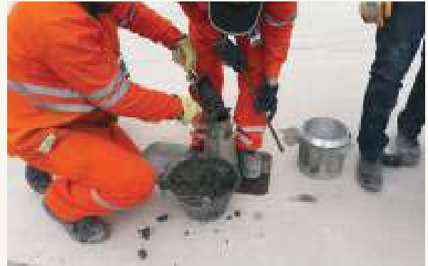
↗ Incorporación de hormigón con cuchara en U
