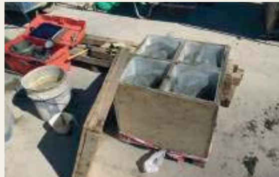
↗ Protección específica en cajas y materiales aislantes en tiempo frío
