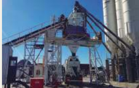
↗ En plantas premezcladoras y verificación de mezclado de mixers, es un ensayo indispensable
