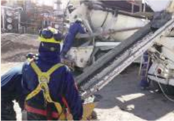
➤ Toma de muestras convencional en obra
