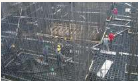
Estructuras masivas en las cuales es muy relevante determinar la temperatura
