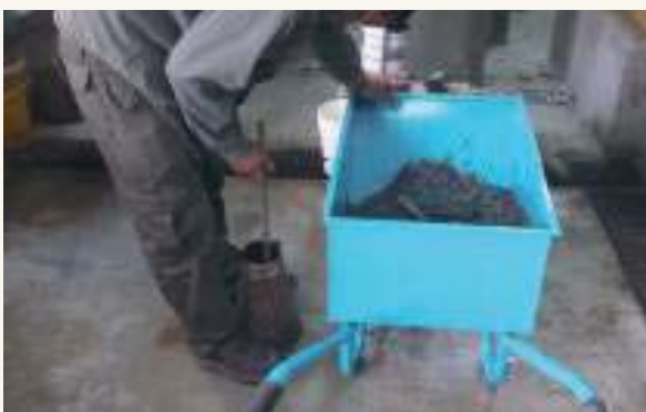
➤ Medición de asentamiento en moldeo remoto (indispensable)
