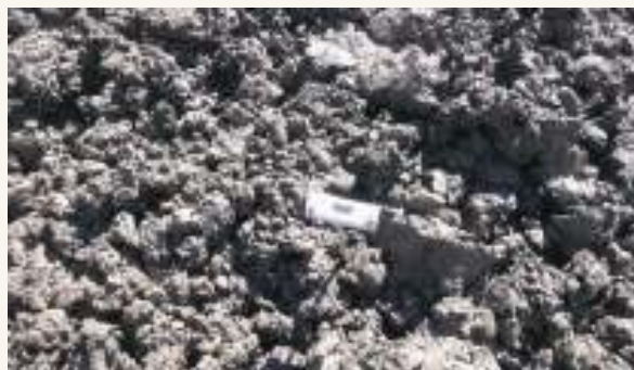
Medición de temperatura con termómetro digital en hormigón colado en la estructura
