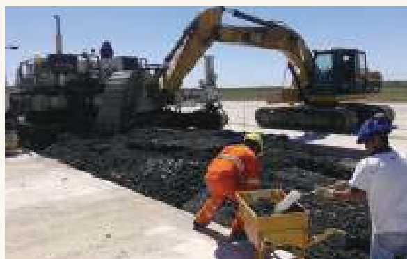
➤ Toma de muestras en obras con Terminadoras de Alto Rendimiento
