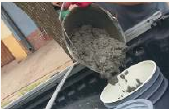
➤ Colocación del hormigón fresco en recipientes para moldeo remoto
