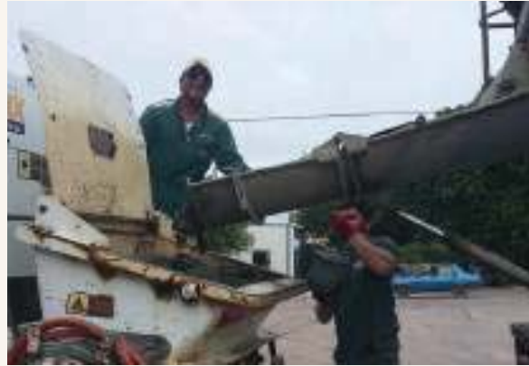
➤ Toma de muestras de la descarga a bomba
