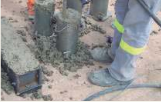
⤴ Moldeo de probetas a flexión y compresión para su posterior correlación en obra de pavimento
