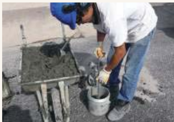
➤ Varillado manual de la primera capa
