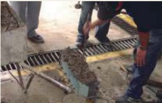
⤴ Varillado del hormigón de la segunda capa (siempre debe existir hormigón sobrante)
