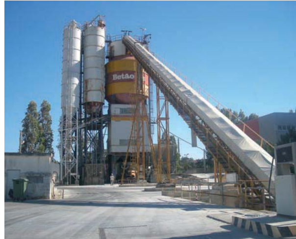
➤ F. 5: Cintas transportadoras con cobertura de lona
