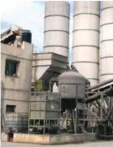
▲ F.17 Murete antiderrame de aditivos
