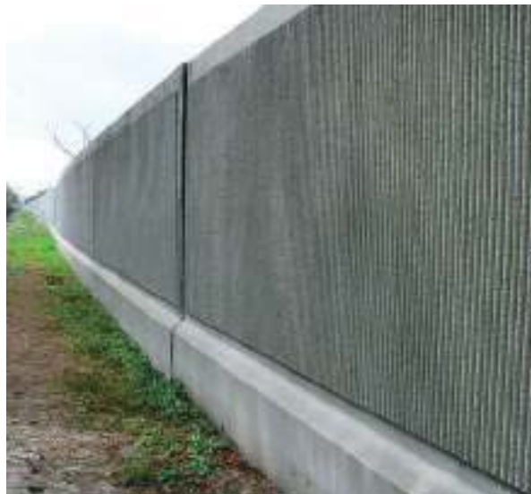
▲ F. 13 Muro para contención sonora
