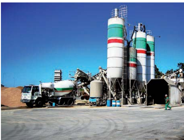
◀ F. 8: Piso impermeable en toda la planta
