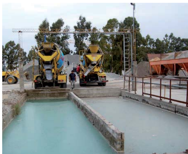
▲ F.11 Lavado de equipos al finalizar la jornada.
