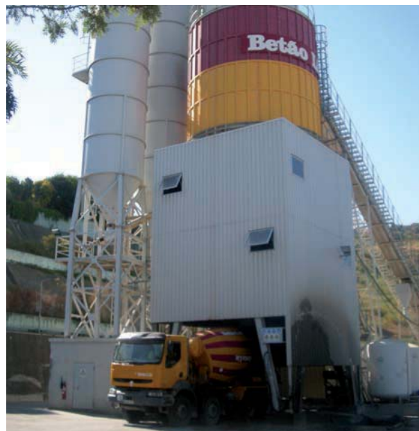
➤ F. 6 bis: Vista exterior de Box de carga con cortina
