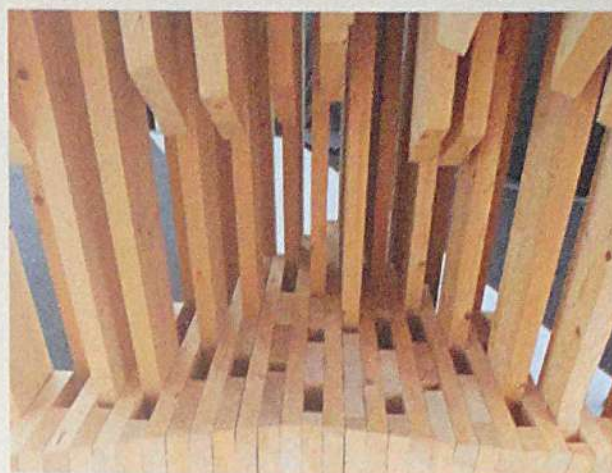
El pabellón Génesis de David Adjaye instalado en la feria de diseño de Miami 2011 se compone de cientos de tablas de madera de iguales dimensiones. Los suelos, paredes y techos se crean con el mismo incremento material y la manipulación del espacio entre las tablas permite los programas de refugio, estructura, entrada, marco, vista, filtración y reposo.
