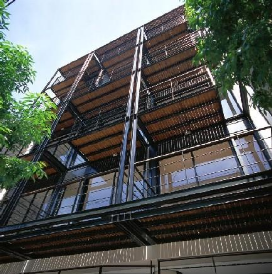
Frente del edificio llevado adelante en la calle Cuba
