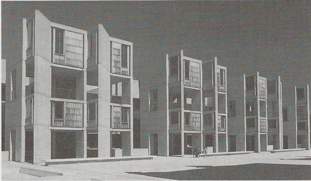
1.8. Louis I. Kahn, Instituto Biológico Jonas Salk, La Jolla (California), 1959-1965. Vista del patio interior. Las zonas de trabajo en equipo están situadas en amplios espacios multifuncionales, mientras que los estudios para análisis individuales están agrupados en el patio central y se comunican con los anteriores mediante escaleras y pasarelas.
