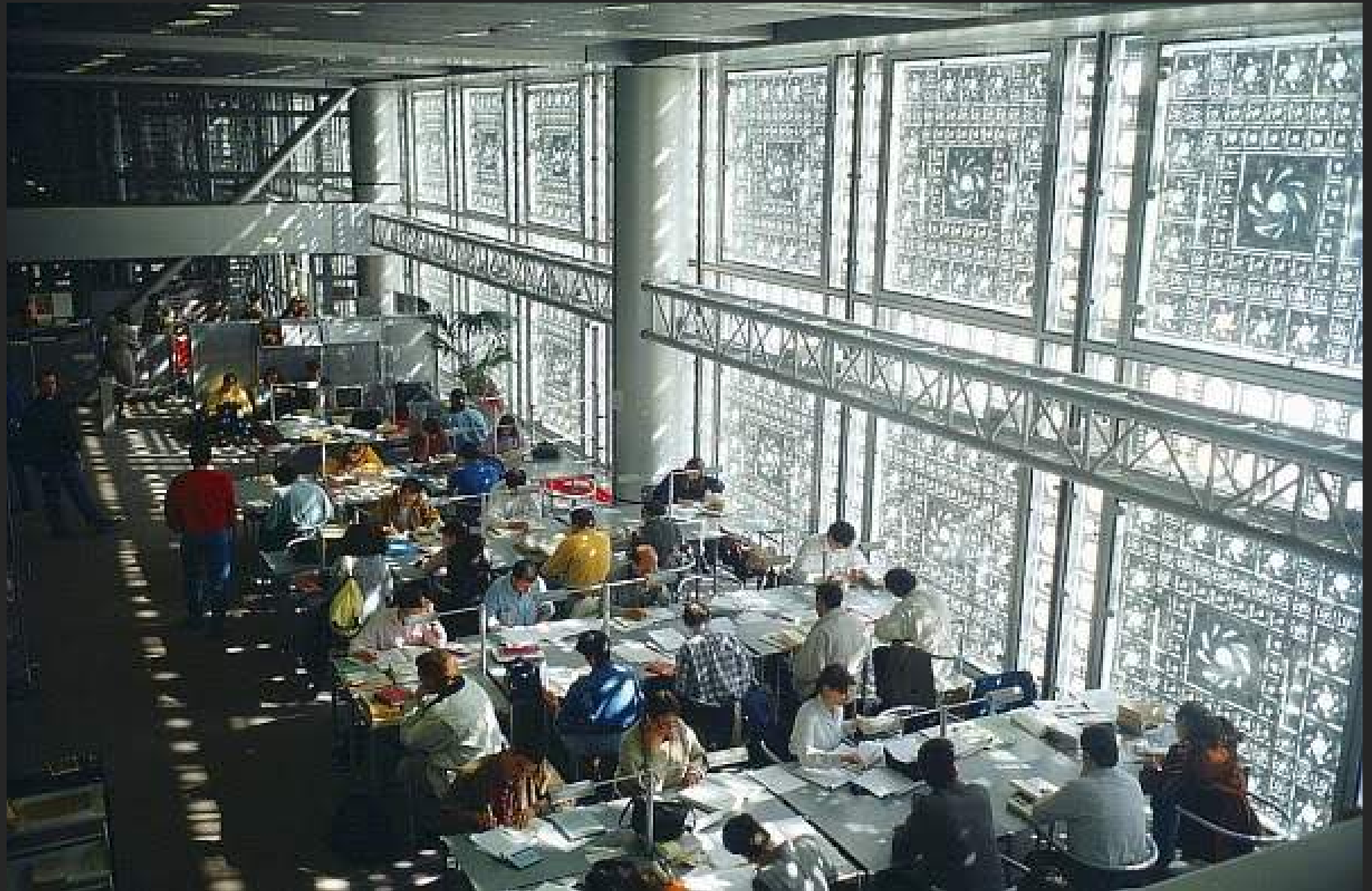
Edificio del mundo árabe, París. Arq. Jean Nouvel
