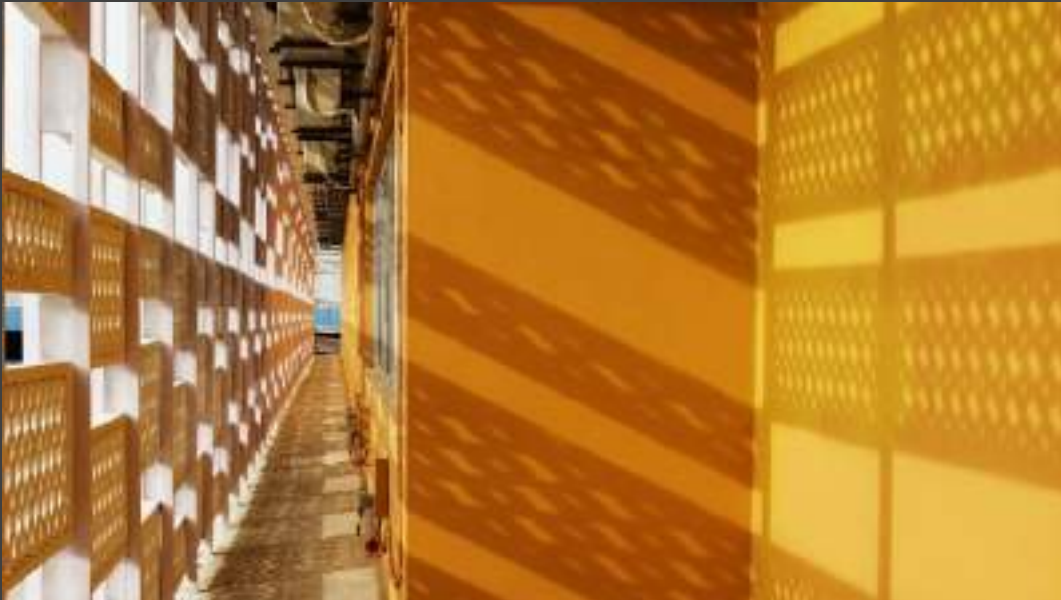
Edificio de la Academia Pearl de Moda, India
