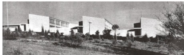
Colegio de la Institución Teresiana en Somosaguas, de Manuel Barbero y Rafael de la Hoz, 1960-1963 (Arquitectura, n. 77, 1983, p. 5).
