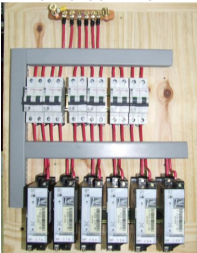
PROTECCIONES TERMOMAGNÉTICAS Y DISPENSADORES. CABLEADO, CONEXIONADO Y DISTRIBUCIÓN SOBRE LA MADERA DEL TABLERO. LAS FOTOGRAFÍAS SON SÓLAMENTE INDICATIVAS
