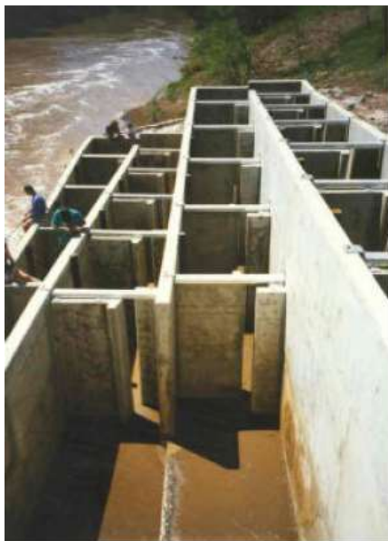
Foto 3. Escala de artesas comunicadas por hendiduras verticales.
