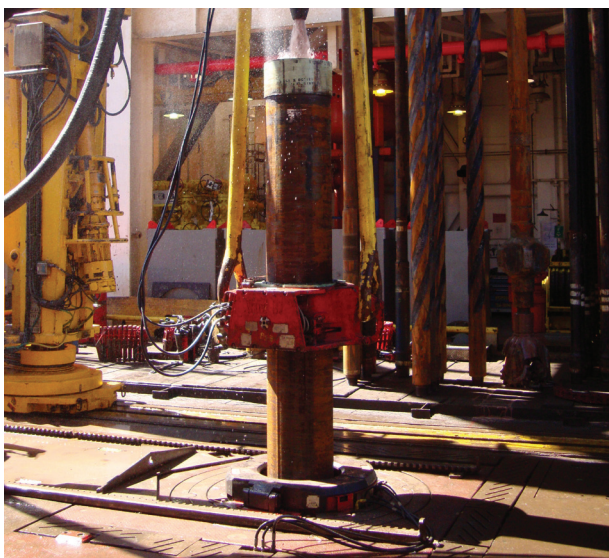
Equipo de perforación
