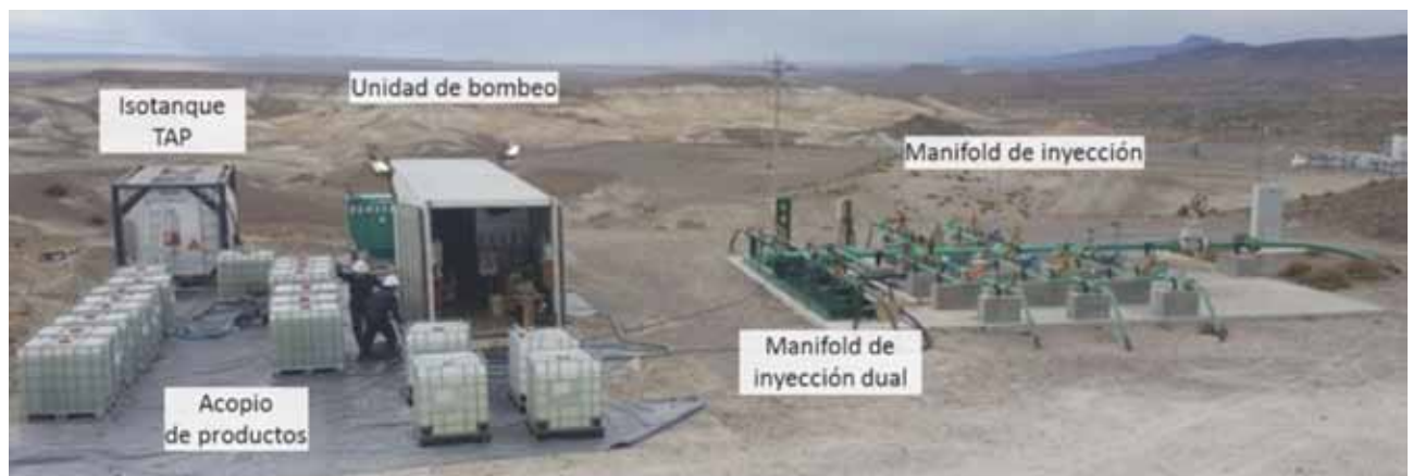
Figura 16. Operación de inyección. Equipos instalados y conectados al manifold.
