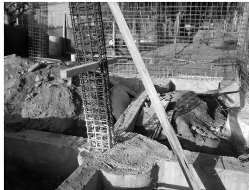
Figura 7.1: Columnas de hormigón armado
