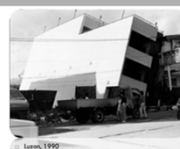
Falla en la capacidad de soporte
