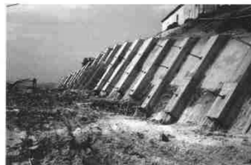
Figura 9.64. Instalación de anclajes para reforzar el talud, unidos mediante vigas de hormigón armado para que trabajen de forma solidaria, Asturias (foto L. González de Vallejo).
