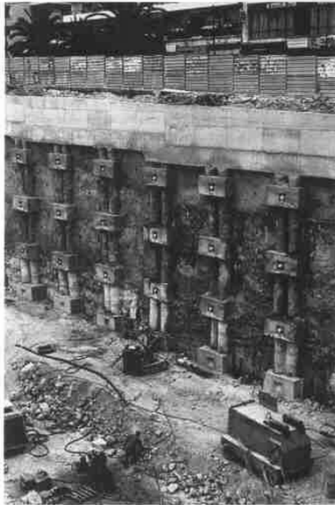
Figura 8.22. Pilotes formando una pantalla (cortesía de Uriel y Asociados, S.A.).
