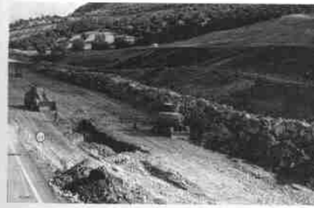
Figura 9.53. Medidas de estabilización en un talud de carretera de la Autovía A-92: colocación de una escollera para reforzar el pie del talud, escalonamiento y retallado del ángulo general y, en primer término, zanja rellena de grava para drenar la zona de pie (foto M. Ferrer).
