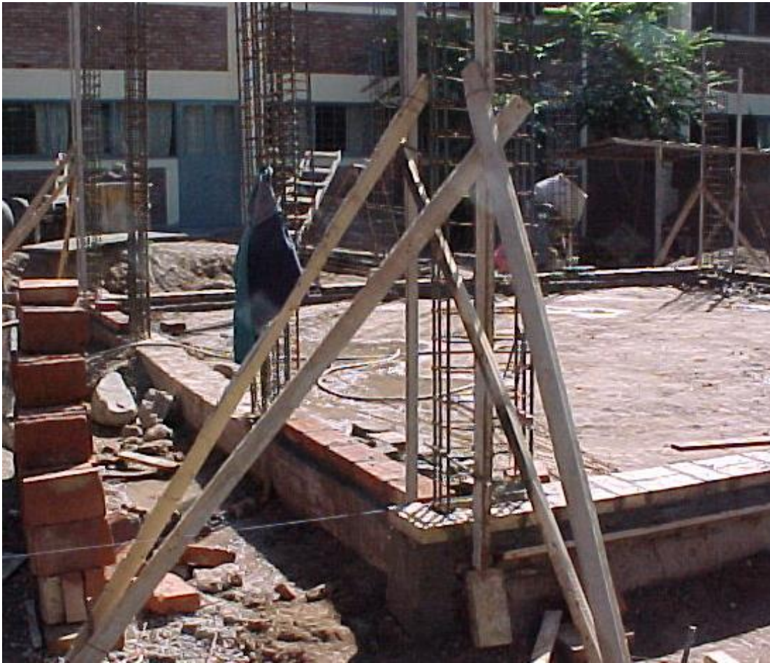
Foto 6. Disposición de puntales para sostener las reglas-guía recién comenzado el muro.
