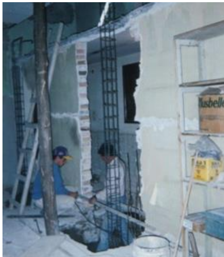
Foto 22. Nueva fundación y columna.
