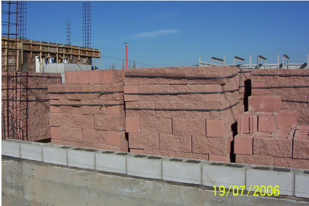
Foto 17. Ejecución de muro de bloques de hormigón y acopio de los bloques.
