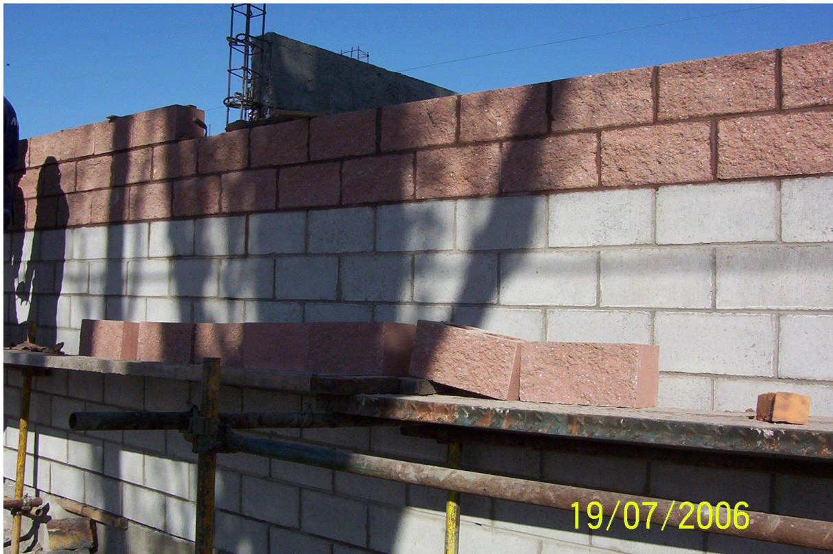
Foto 18. Ejecución de muro de bloques de hormigón.
