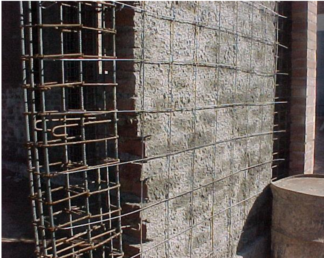
Foto 14. Muro de mampostería armado.
