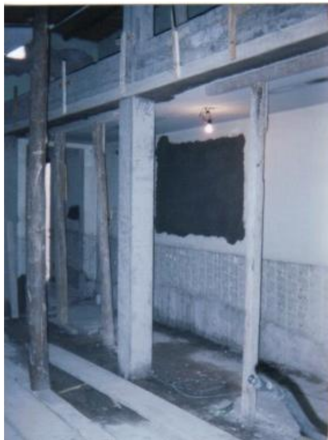
Foto 24. Retiro del muro. Apertura de vano finalizada.
