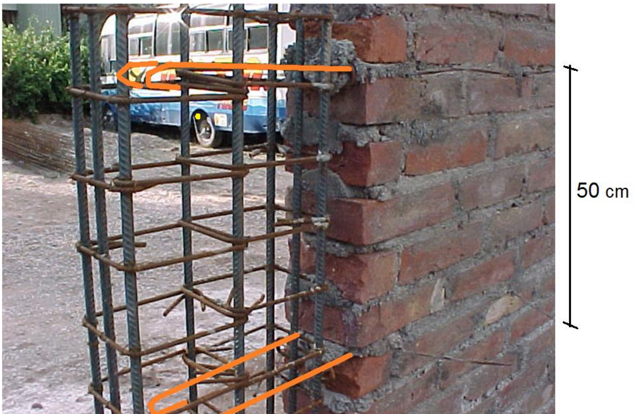
Foto 13. Mampostería reforzada: anclaje del hierro de refuerzo en la columna de H^{\circ}A^{\circ} .
