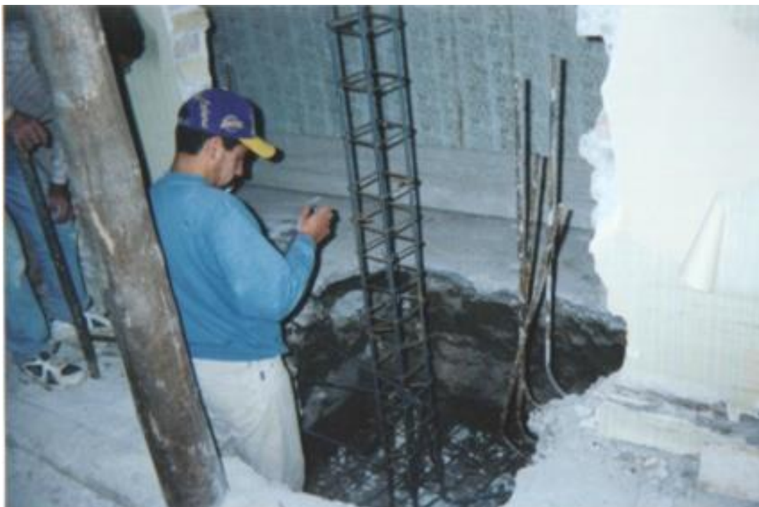
Foto 20. Nueva estructura columna y base en la apertura de vano.
