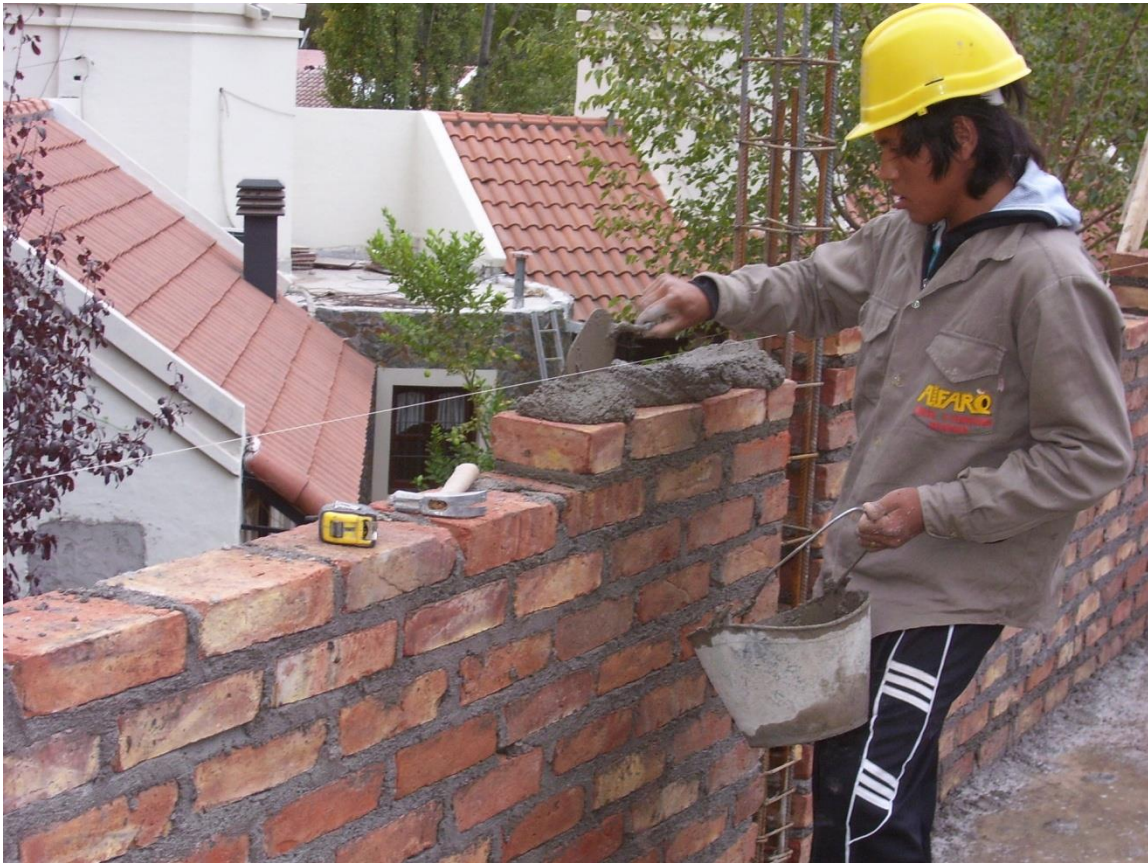
Foto 4. Ejecución de un muro de 20 cm.
