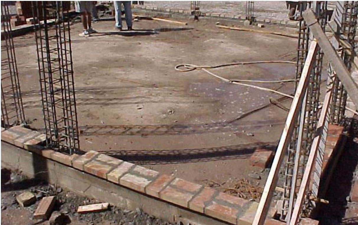
Foto 2. Ejecución de muro de 30 cm de espesor.
