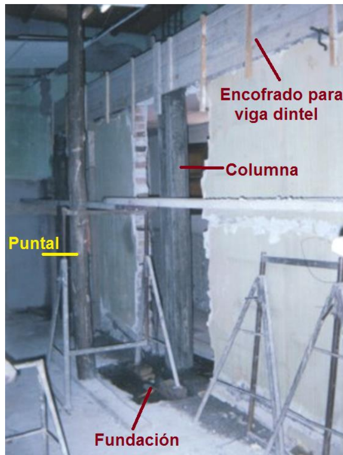
Foto 23. Columna y fundación hormigonadas. Viga dintel encofrada.
