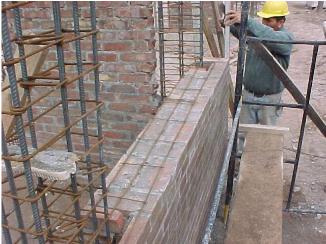
Foto 11. Mampostería reforzada: armadura de hierro entre hiladas.
