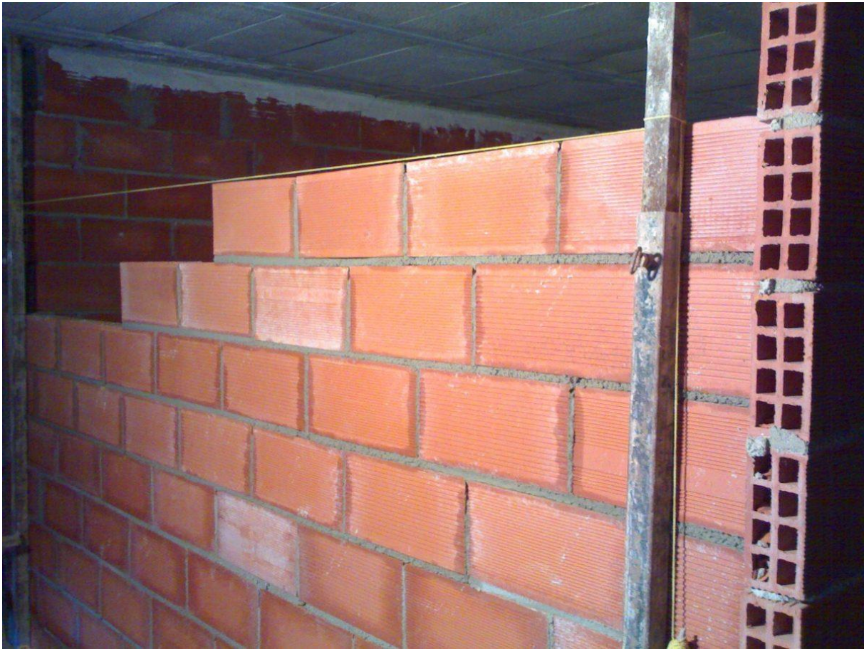
Foto 19. Ejecución de muro con ladrillo cerámico hueco.
