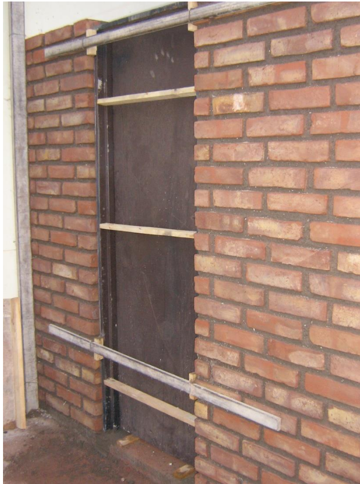
Foto 16. Ejecución del muro con colocación previa de la abertura.
