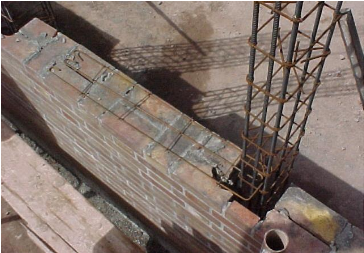
Foto 12. Mampostería reforzada: armadura de refuerzo, anclada a la columna.
