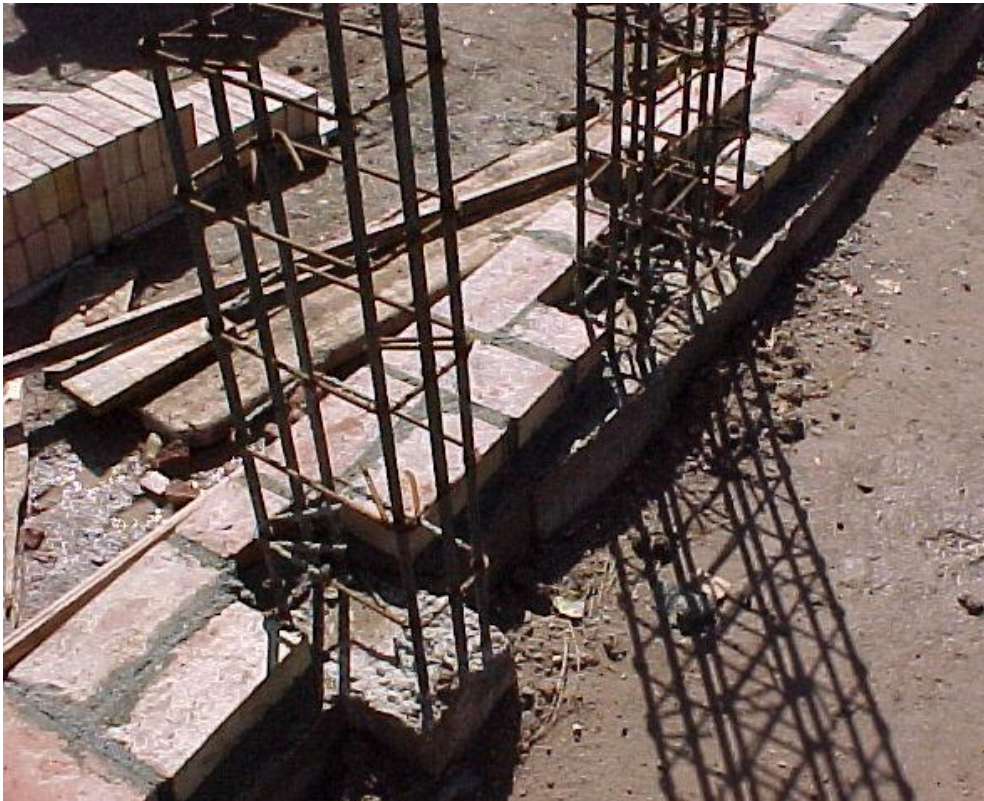
Foto 7. Solución en muro de 30 cm con columnas.
