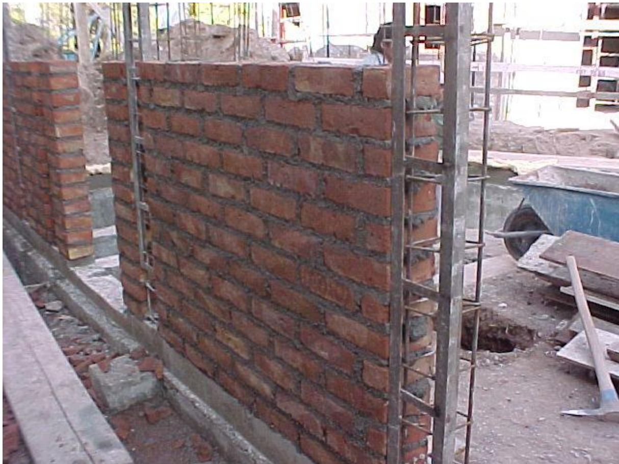
Foto I. Ejecución de muro de 20 cm de espesor.
