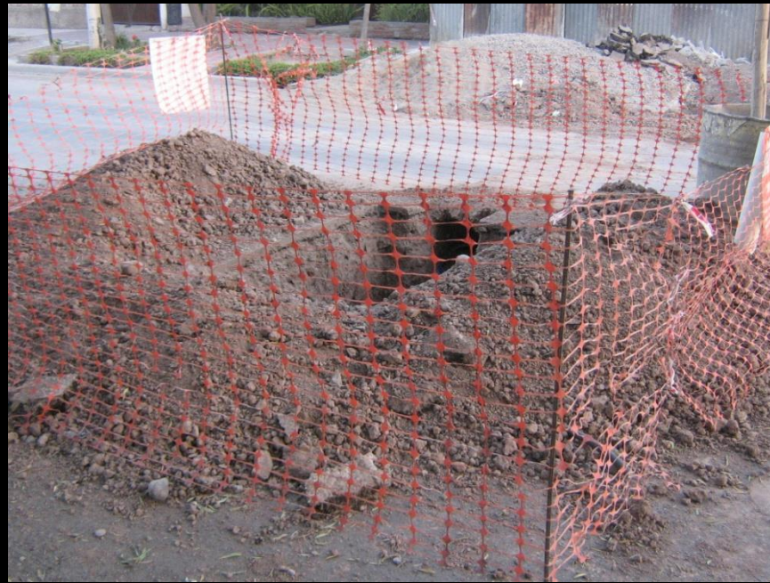
Pozo para conexión
