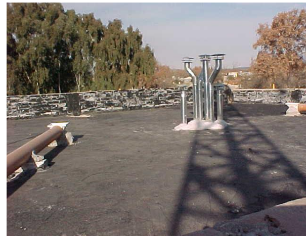
Colación barrera de vapor con pintura asfáltica
