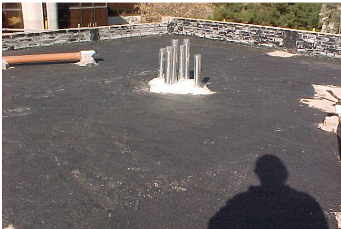
Colación barrera de vapor con pintura asfáltica
