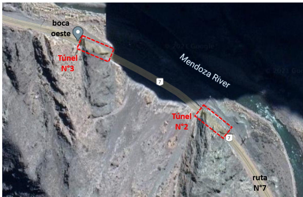
Fig 2. Vista satelital del área de ubicación del Túnel N°2 y N°3 y de la boca oeste donde se sitúa el talud a ser estudiado (Fuente: Google Maps).
