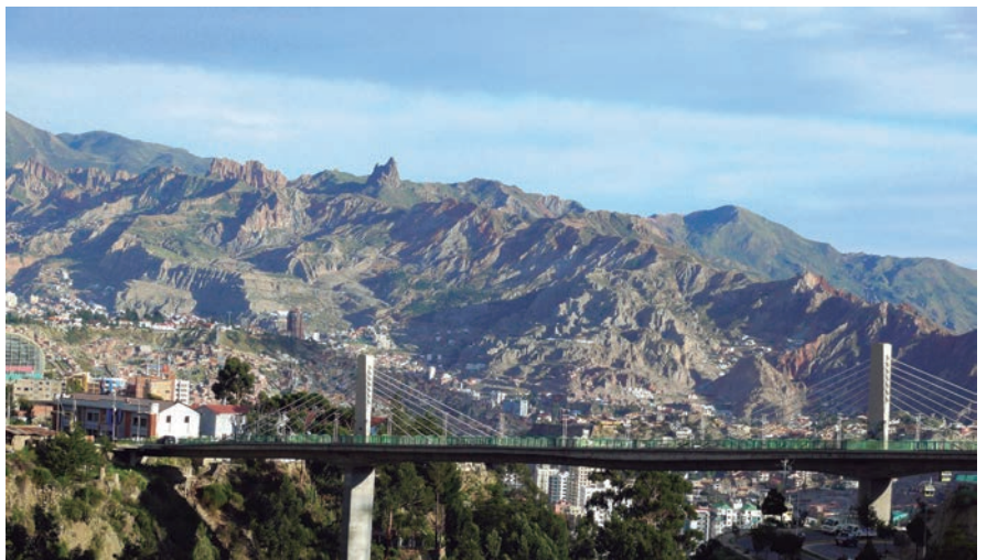
Figura 2.8. Al entender a la ciudad como un ecosistema, un puente puede comprenderse como un elemento más de éste, y analizarlo en virtud de los servicios y anti-servicios. El puente permite ahorrar tiempo en el traslado de una ladera a otra proporcionando los beneficios a los ciudadanos de evitar el estrés, pasar más tiempo con la familia, disminuir la cantidad de combustibles utilizados y por ende la emisión de gases de efecto invernadero. Dependiendo de su diseño y la forma como se integra estéticamente con el paisaje, podría bien representar anti-servicios estéticos al alterar el paisaje, o por el contrario representar un componente indisoluble del paisaje, llegando a ser incluso un elemento generador de identidad (Fotografía del autor).
