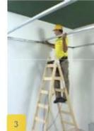
4. Colocar los Travesaños, vinculados a los Largueros mediante el sistema de encastre de los cabezales. Controlar y corregir el nivel de la estructura.
